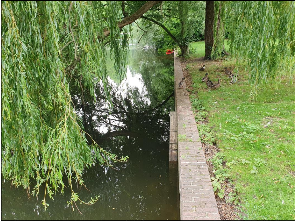
Figuur 3 De kade van de bestaande Osdorpergracht.
