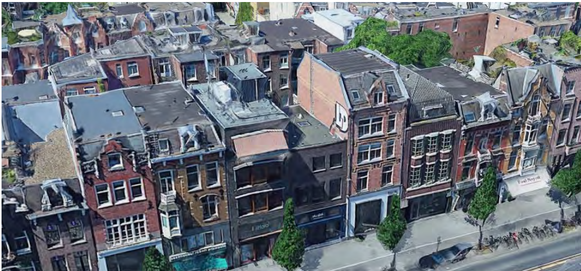
Het gebouw gezien van bovenaf in oostelijke richting.
