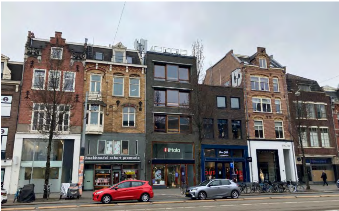
Gevelaanzicht vanaf de Van Baerlestraat.
