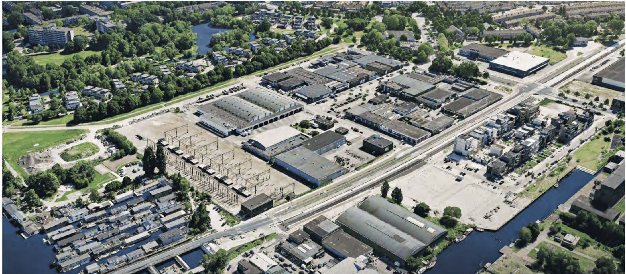
Luchtfoto huidige situatie Klapprozenbuurt, vanaf zuidwesten
