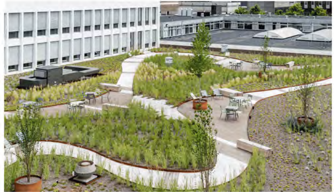
Voorbeeld van een groen dak (Vivaldi Zuidas)
