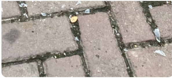
Ook aan de andere kant van de tunnel
