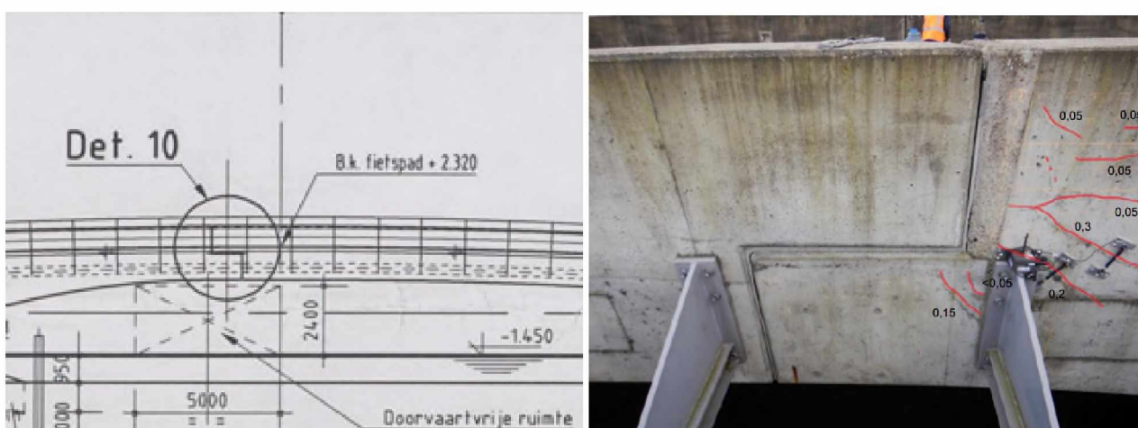
Figuur 3: Locatie oplegpunt met schade op tekening en indicatieve foto van geconstateerde schade.
