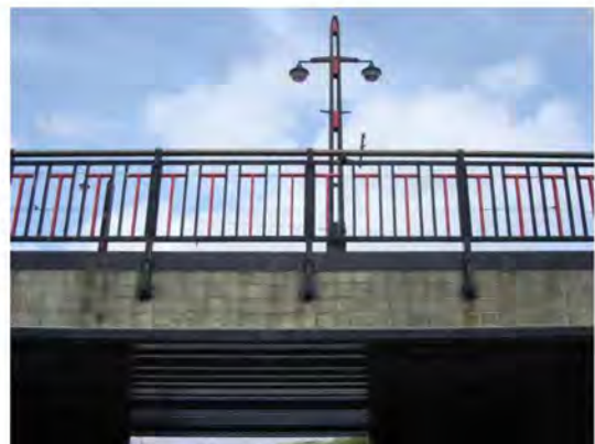
Foto 14 aansluiting leuning aan brugdek.
