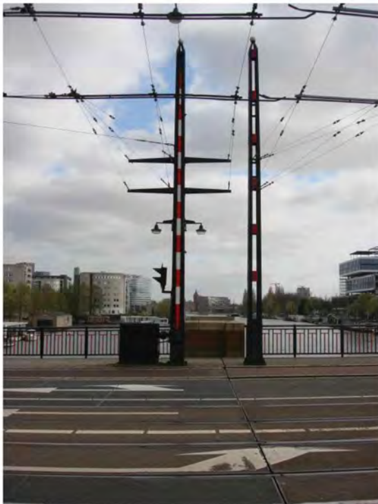
Foto 17: masten t.b.v. spankabels
