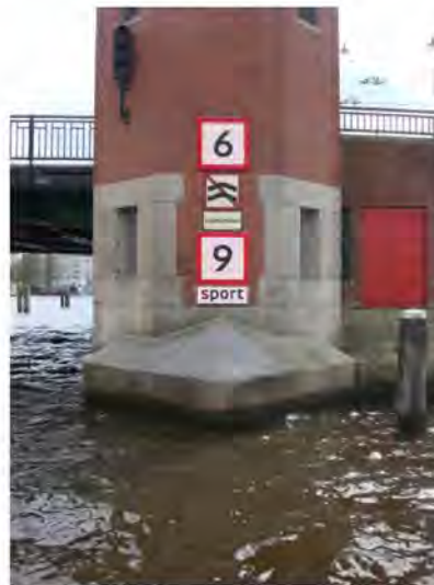
Foto 6: voet kelderpijler (brugwachtershuisje)
