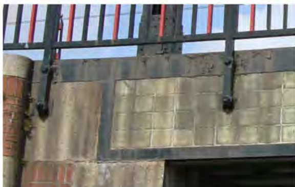
Foto 15: bevestiging leuning aan brugdek.
