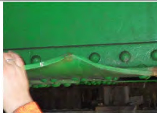
Detailfoto 11: Deformatie flens dwarsdrager
