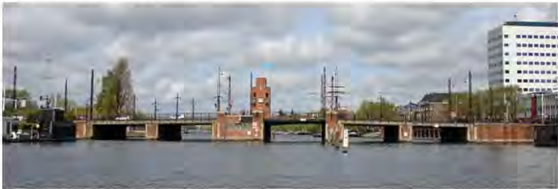
Foto 1: aanzicht Berlagebrug zuidzijde
