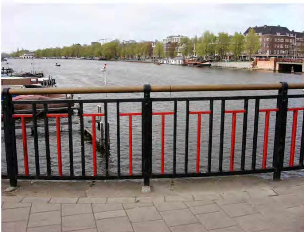
Foto 14: aansluiting leuning aan natuursteen banden.
