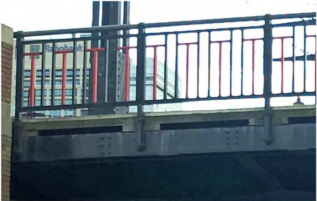
Foto 20: randligger val met houten trottoirconstructie.
