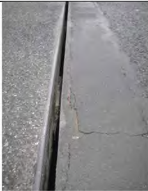
Detailfoto 19: Afname slijtlaag voegovergang voorhar
