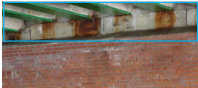
Foto 33: roestvorming oppervlak natuursteen
