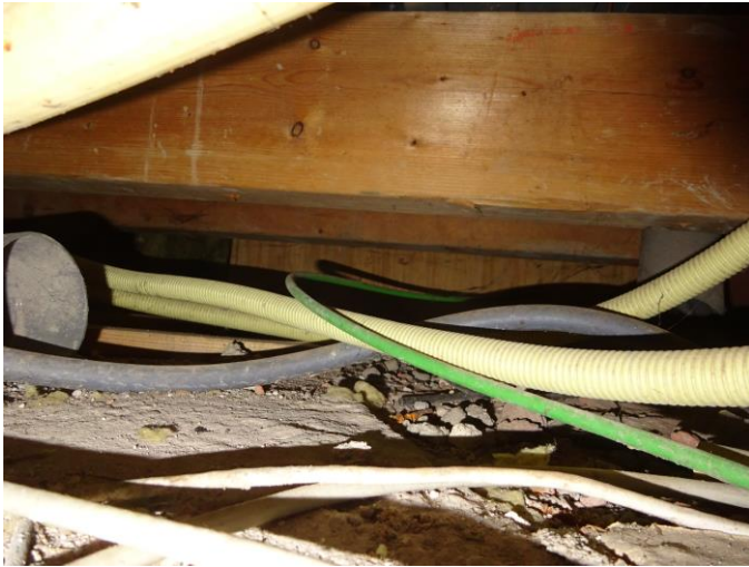
Kruipruimte met PVC riolering
