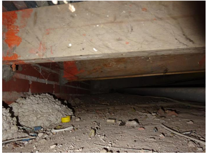
Kruipruimte met PVC riolering
