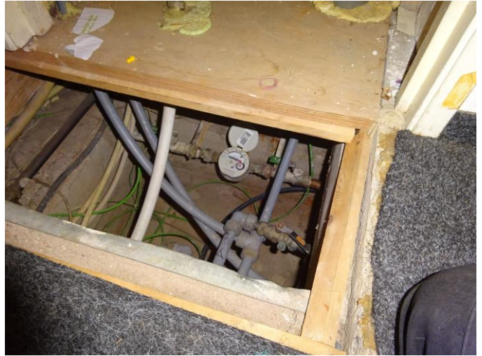
Kruipruimte met PVC riolering
