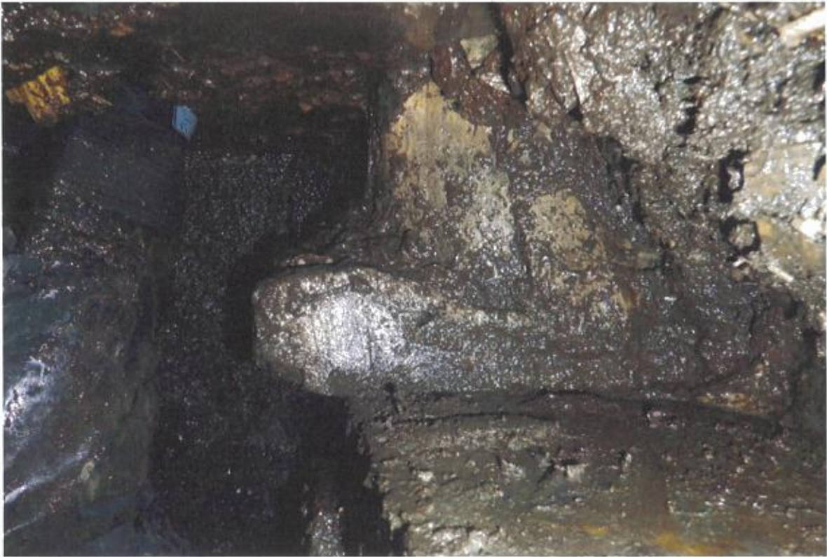
langshout 1, kesp 2 en paal 2 (kesp 2 is 50% samengedrukt)
