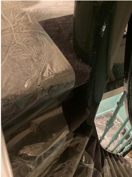
Figuur 42. Aangelegd tapijt met dempend materiaal
