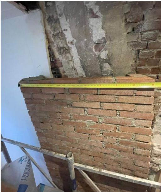
Figuur 27c. teruggeplaatste schoorsteen op de 3 e verdieping
