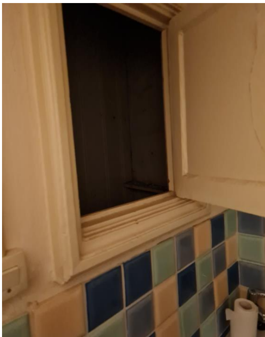
Figuur 39. Oude situatie ventilatieschacht zonder leidingen
