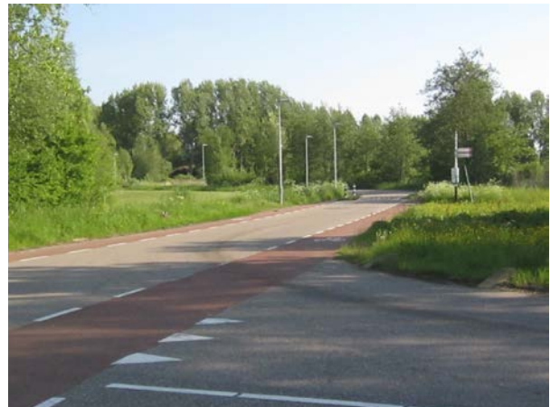
toegangsweg met links het dagkampeerterrin
