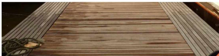
Afbeelding 4: referentie afwerking zijkant steiger
