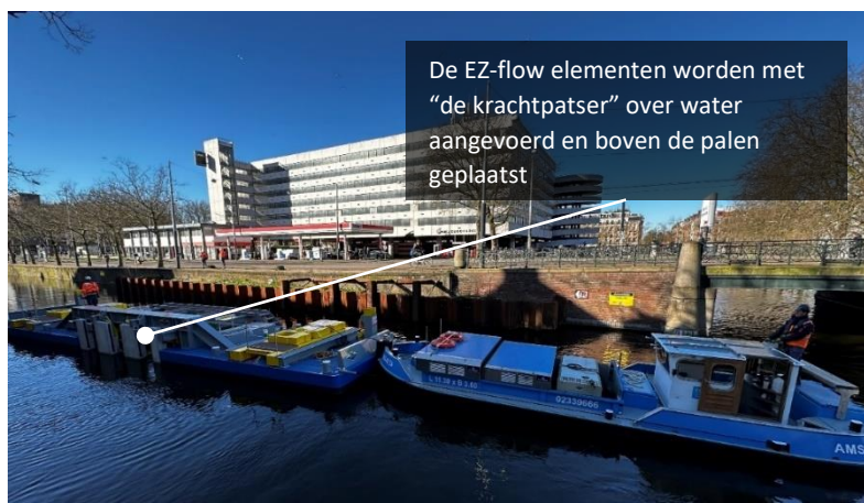
Figuur 9: Aanvoer EZ-flow elementen over water.
