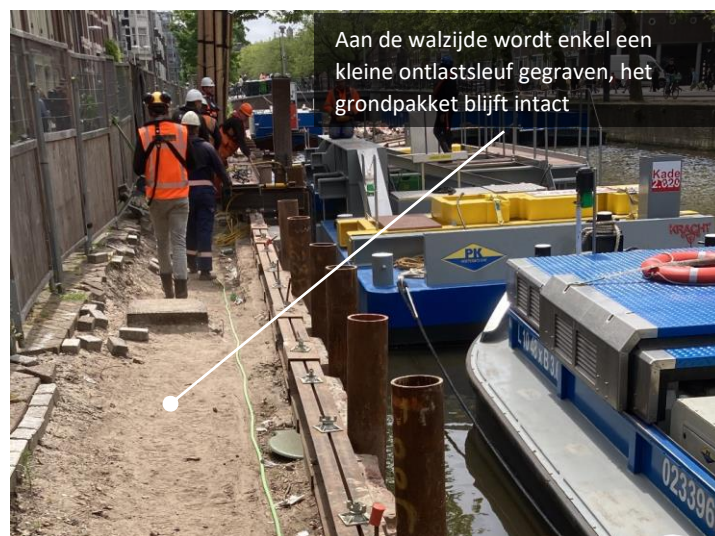
Figuur 11: Uitvoering werkzaamheden ter plaatse van de Lijnbaansgracht.
