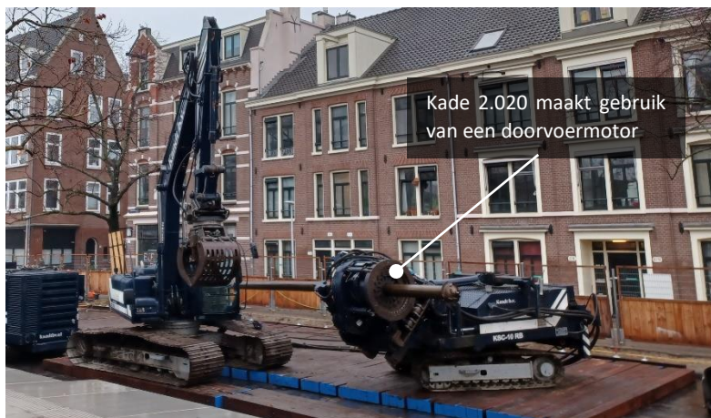
Figuur 8: Heistelling met doorvoermotor
