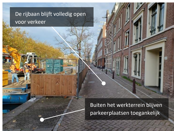
Figuur 10: Uitvoering werkzaamheden t.p.v. de Lijnbaansgracht.
