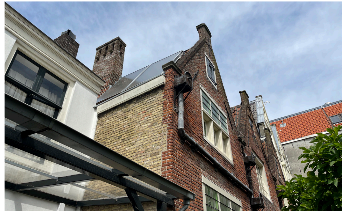
Achtergevels 5.1, 2, e 93 - huidige situatie
