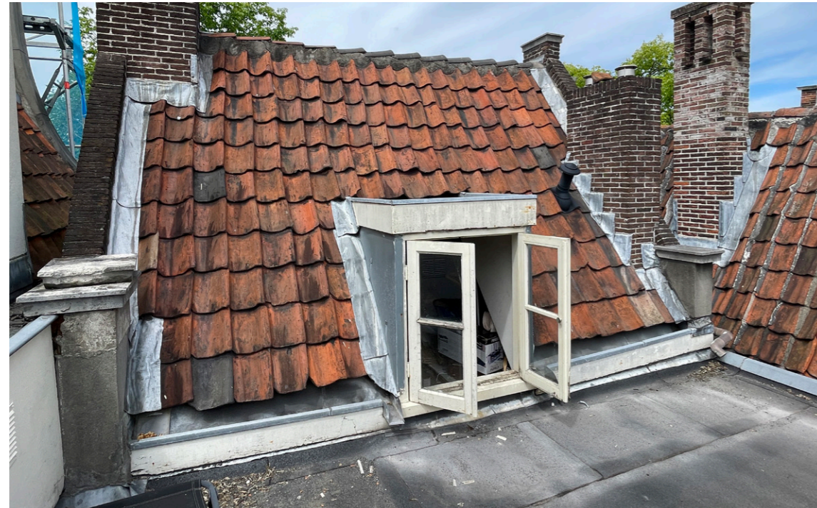
Achterzijde zadeldak - huidige situatie
