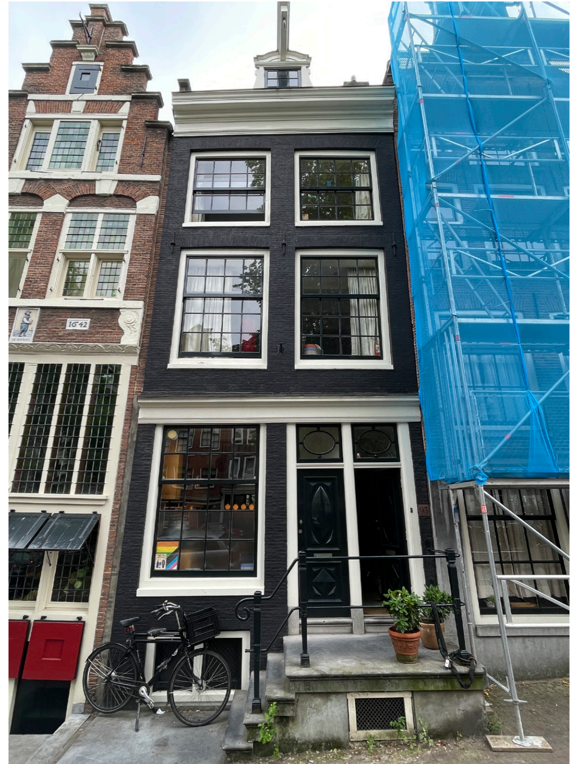
Voorgevel 5.1, 2, e - huidige situatie
