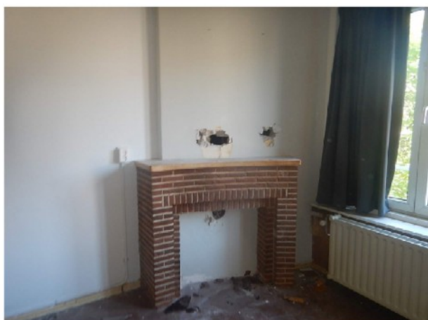
Schoorsteen opgemetseld, geen asbestverdachte toepassingen aangetroffen.
