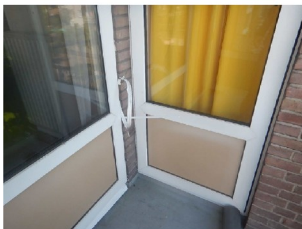
Borstweringen / kozijnplaten niet asbestverdacht, volkern platen.
