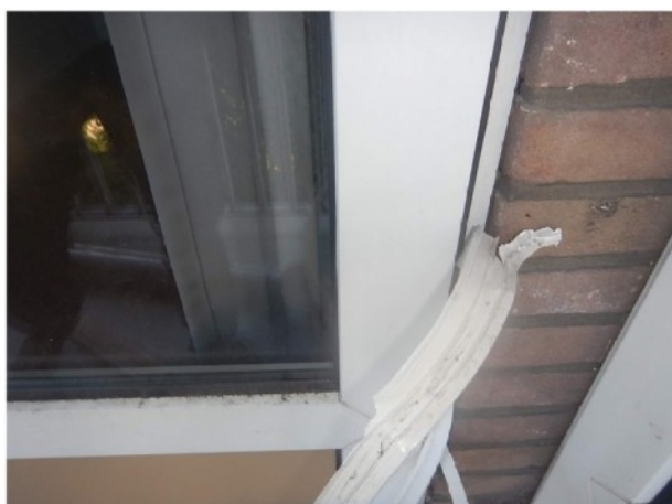
Tussen kunststof kozijn en metselwerk (buitengevel) licht destructief onderzoek uitgevoerd. Geen asbestverdachte toepassingen aangetroffen.
