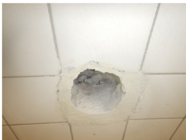
Doorvoer in de buitegel, t.h.v. de keuken huisnr:17-H. Geen asbestverdachte toepassingen aangetroffen.
