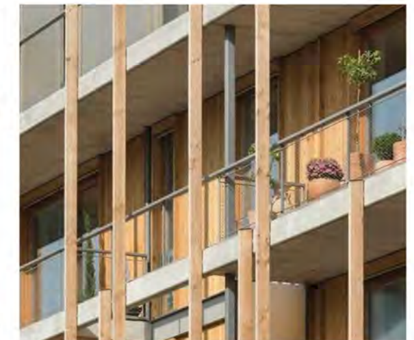
houten constructie galerij
