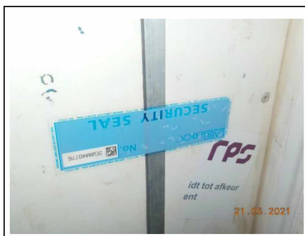
Foto 12: Het containment is verzegeld tijdens de luchtmeting.
