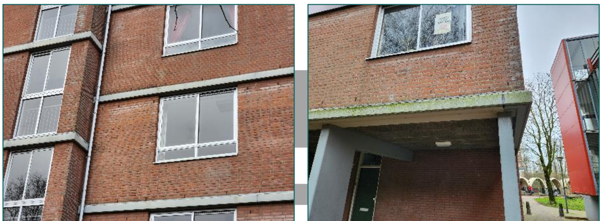
Figuur 3.1 Voorbeelden van openingen (stootvoegen) die vleermuizen toegang verlenen tot een geschikte verblijfplaats (in deze de luchtspouw).
