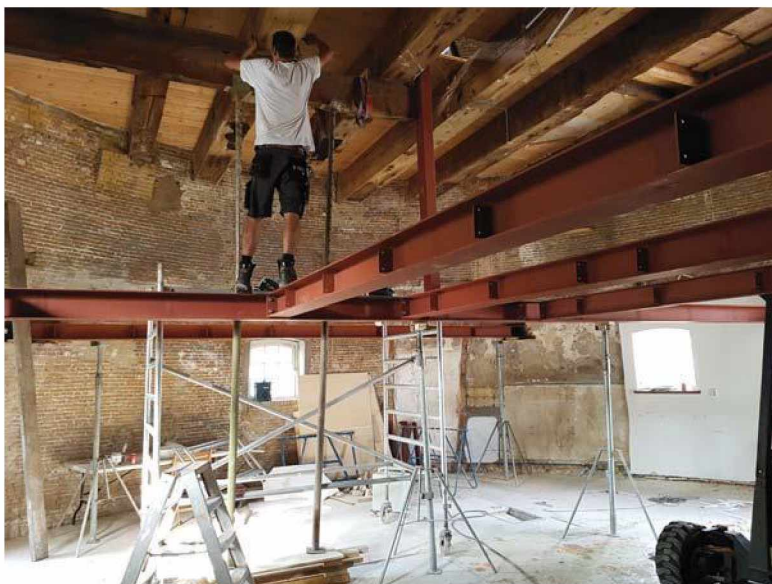
constructie van staal
