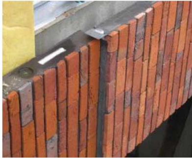
geprefabriceerde onderdelen met baksteen strips
