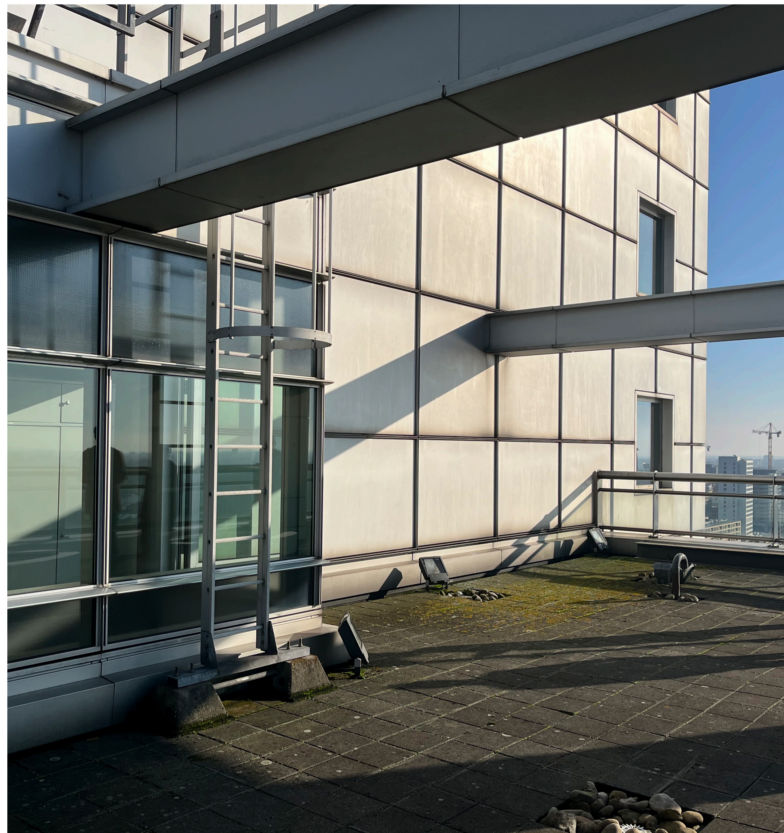
positie uitbreiding op dak
