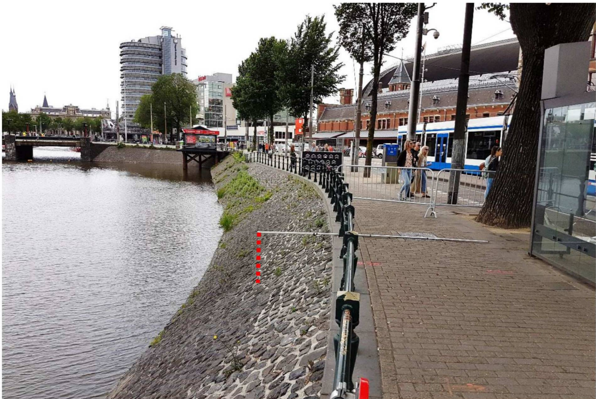
Rond boom 32 (op de foto rechts) wordt het maaiveld op de kade verhoogd. De kade wordt hier ook ruim 1,4 meter breder. De rode stippellijn duidt aan tot hoe ver deze verbreding reikt.
