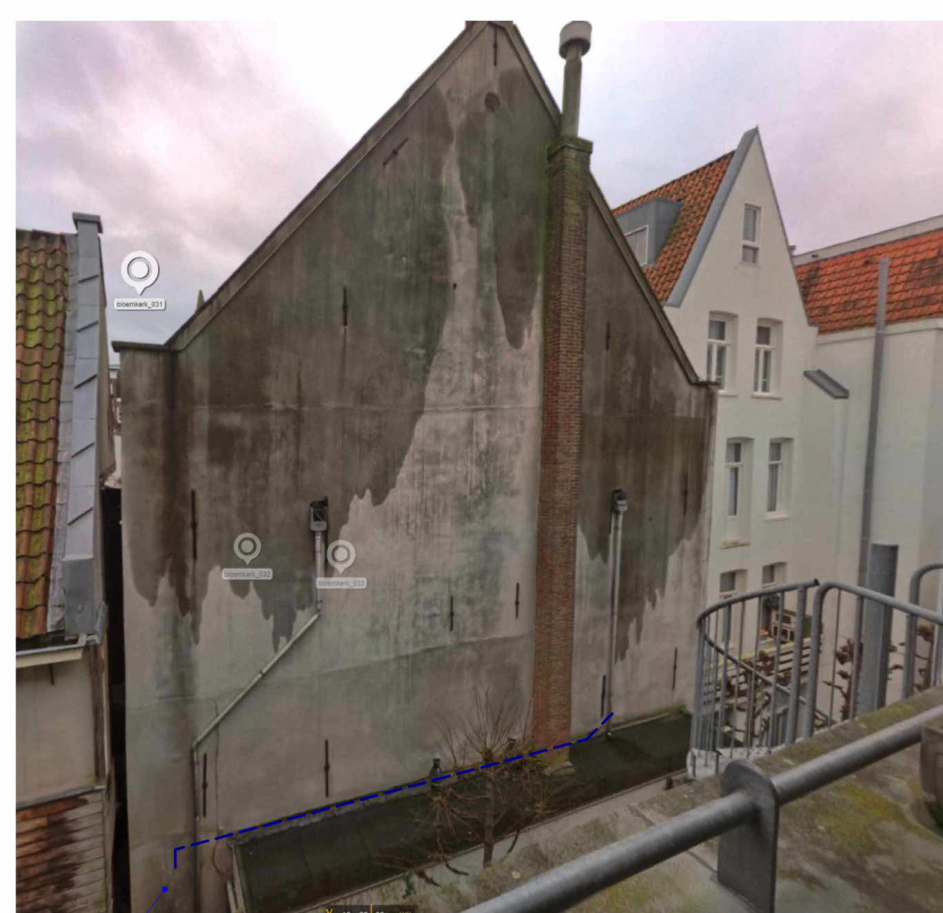
SITUATIE HEMELWATERAFVOER ACHTERGEVEL
