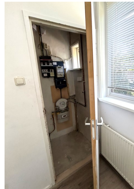
meterkast en gasleidingen t.p.v. voorgevel
