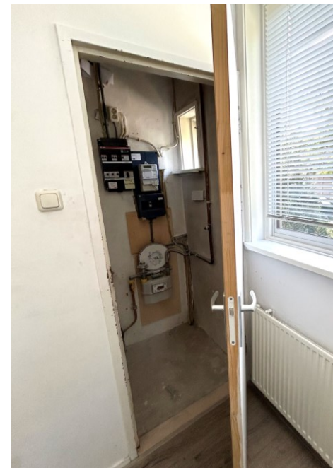
deurkozijn bij voorgevel
