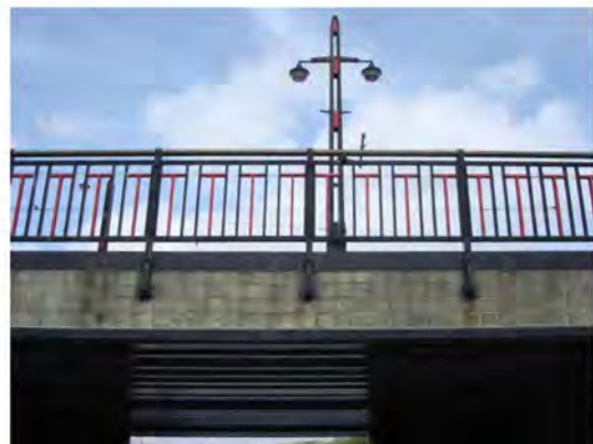
Foto 14 aansluiting leuning aan brugdek.
