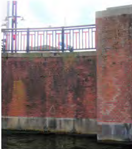
Foto 34: geheel matig tot slecht. Voegwerk metselwerk Foto 35: matig tot slecht voegwerk natuursteen.
