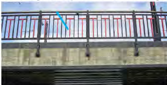
Afbeelding 1. Leuningwerk tegen randligger brugdek
