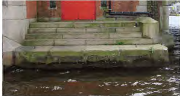
Foto 34: geheel matig tot slecht. Voegwerk metselwerk Foto 35: matig tot slecht voegwerk natuursteen.
