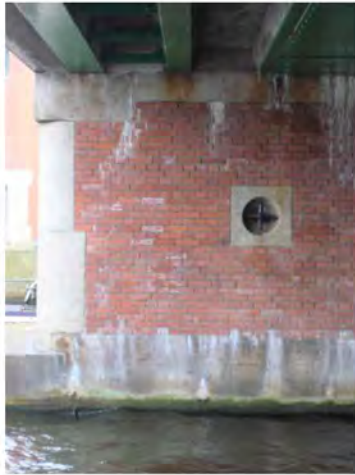
Foto 20: Calcietuitbloeiingen. (witte uitslag op Metselwerk en natuursteen).
