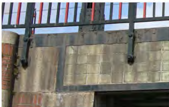
Foto 15: bevestiging leuning aan brugdek.
