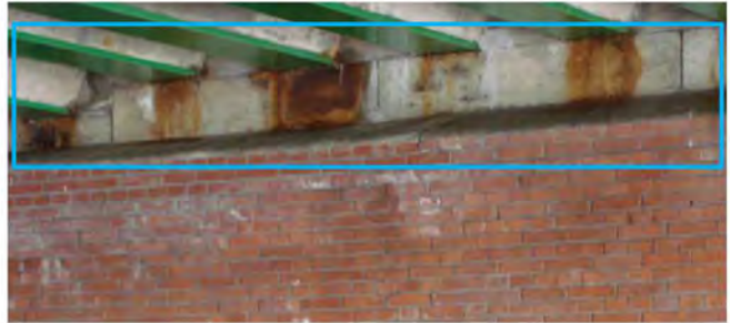
Foto 31: roestvorming oppervlak natuursteen
