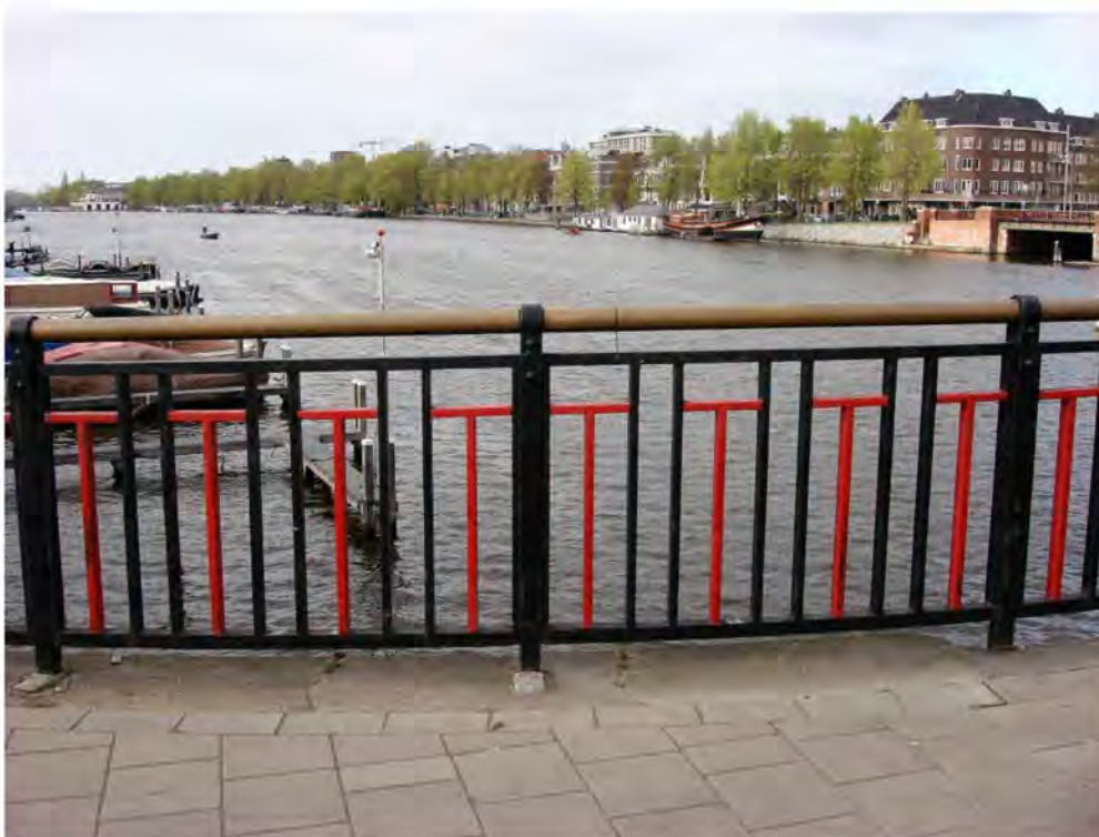
Foto 14: aansluiting leuning aan natuursteen banden.
