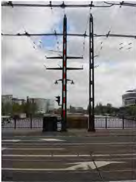
Foto 17: masten t.b.v. spankabels
