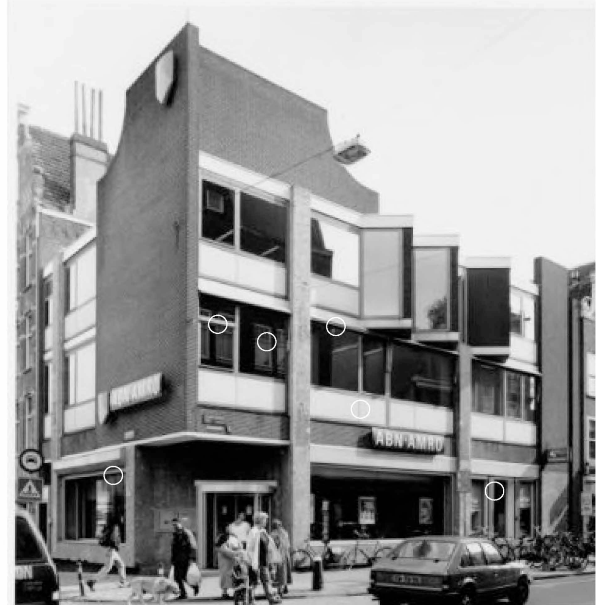
Na transformatie door Buro A.Staal, conform tekeningen uit 1981-1984
