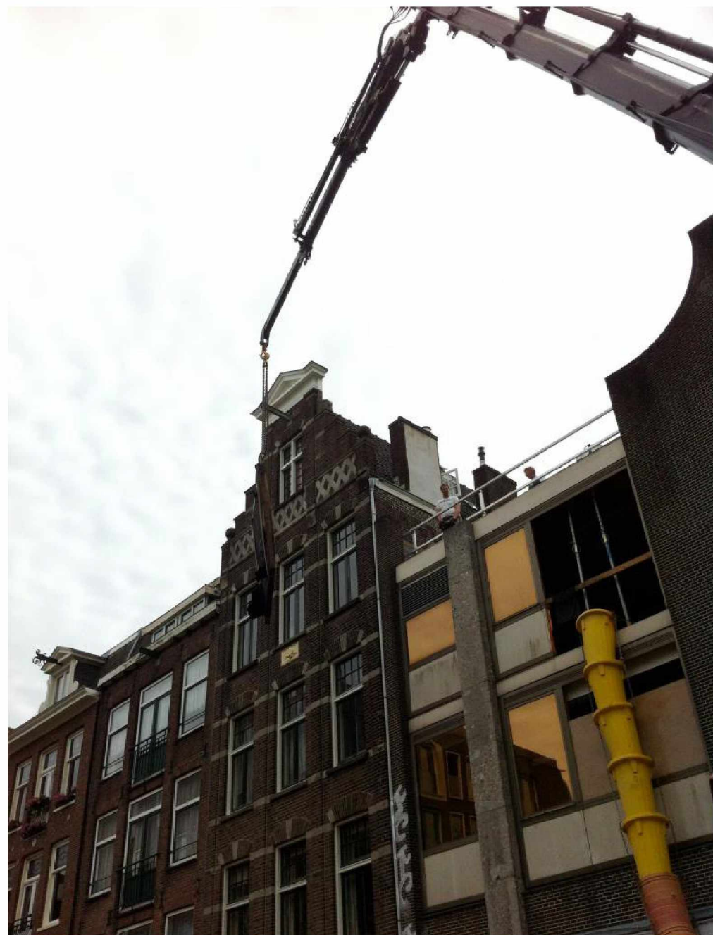
Tijdens de renovatie in 2012
