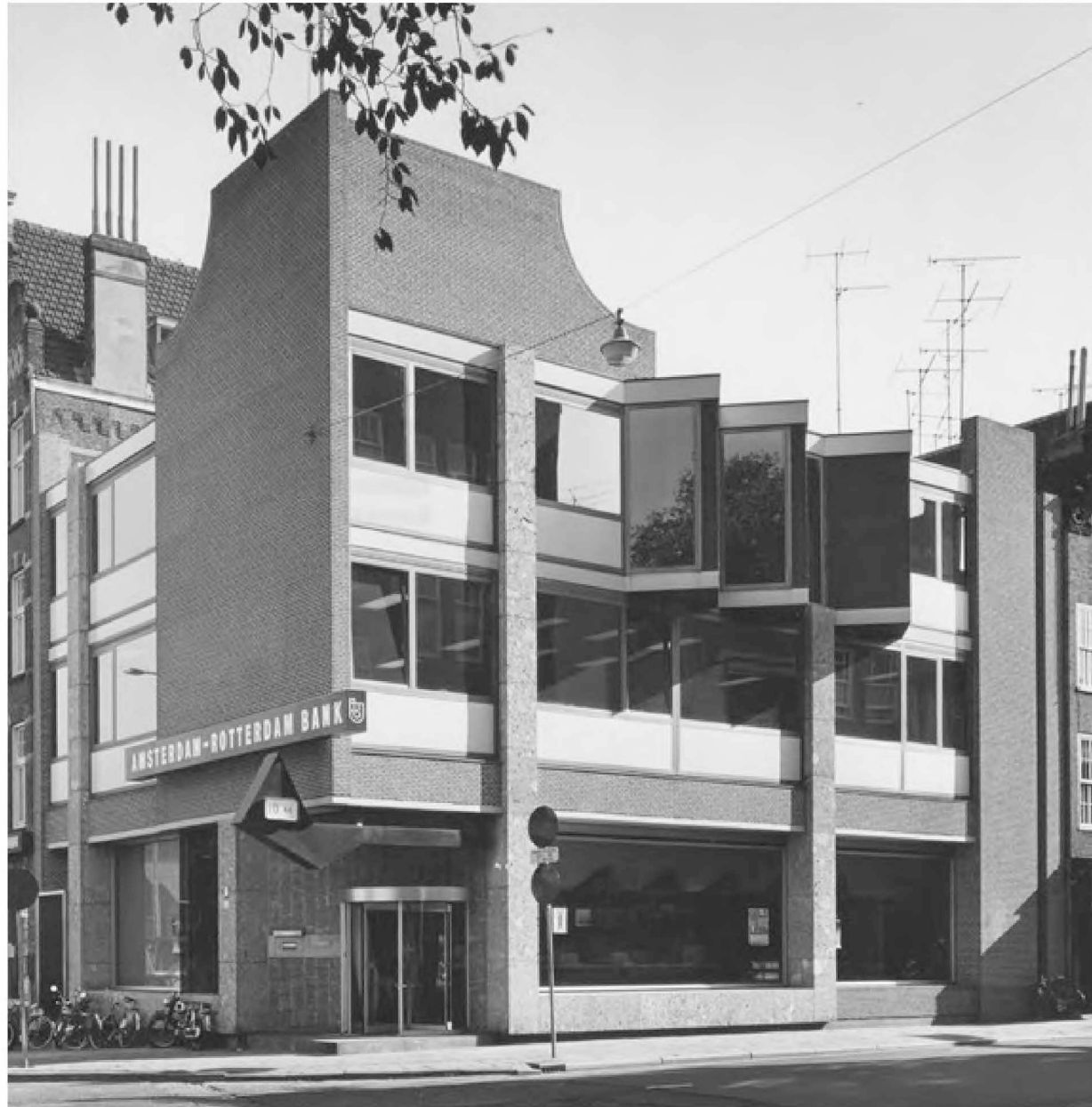
Het gebouw na de oplevering, gebouwd conform de tekeningen uit 1972
