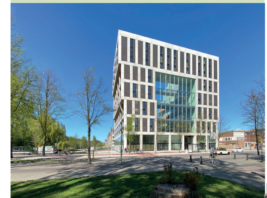
Gevel met open en levendige plint. Olaf Gipsier Architects, Smartland, New West, Amsterdam 2020
