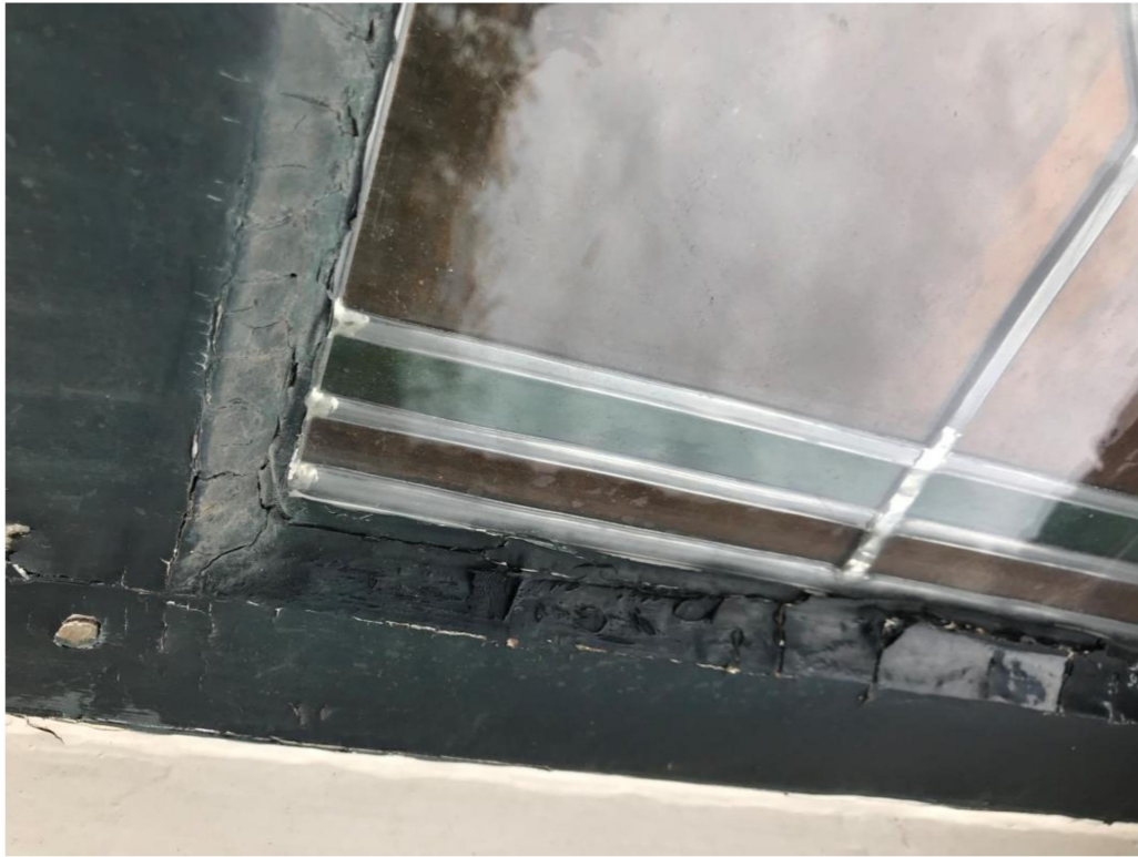
Reeds glas voor glas in lood geplaatst
