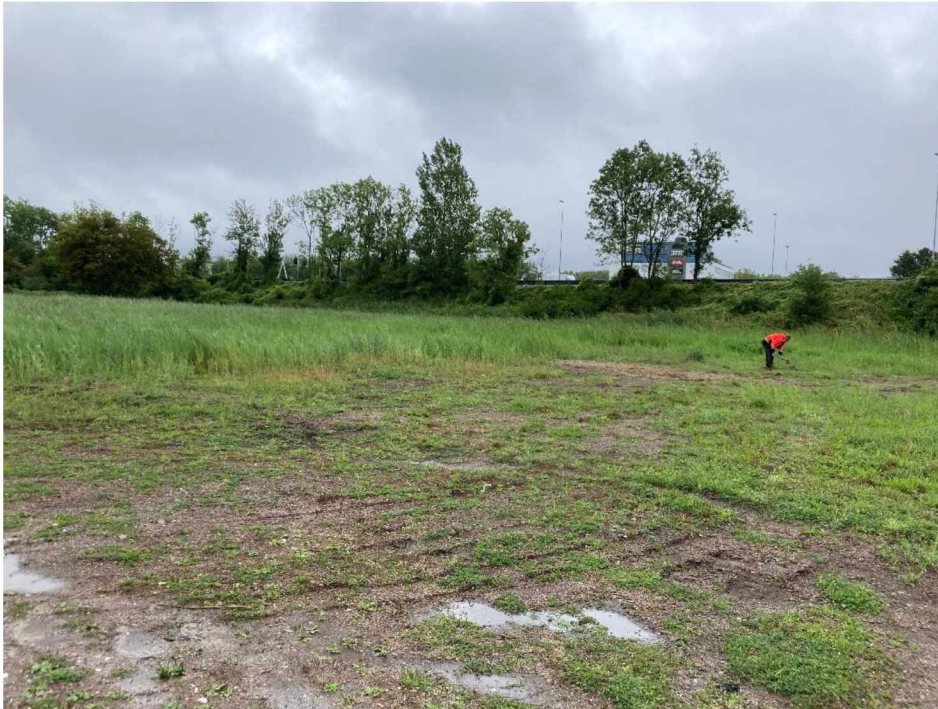
INSPORINGEN IN TERREIN EN ONTBREKENDE GRASBEZETTING
