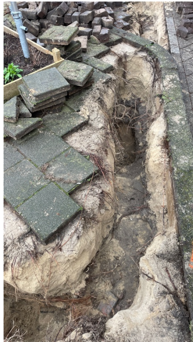
Afbeelding 18: Fijne beworteling in boomspiegel aan de straatkant
