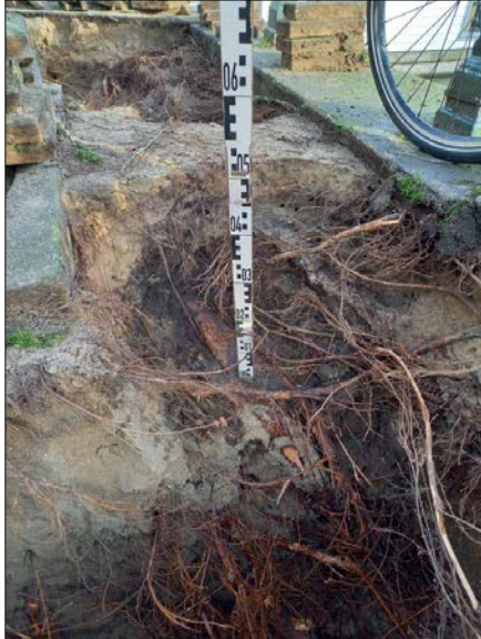
Dikke gestelwortels parallel aan kade bij brughoofd
