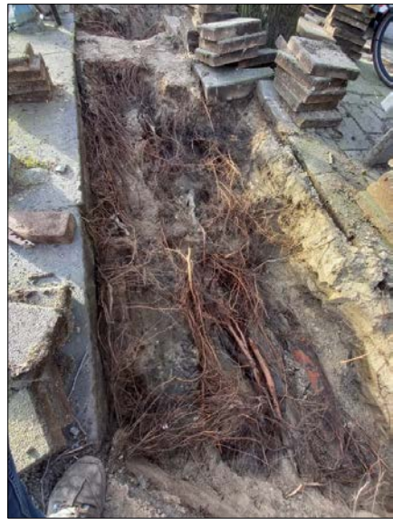
Zeer dikke gestelwortels tegen uitkragende muur
