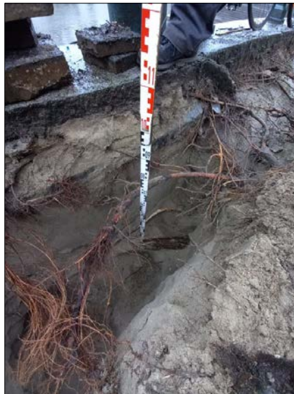
Diep liggende gestelwortels langs kade
