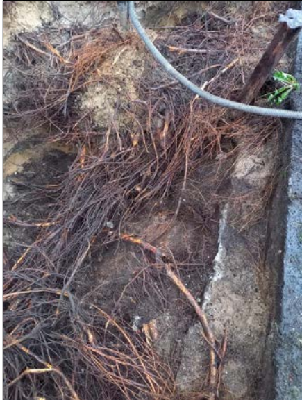
Zeer intensief pakket haarwortels tegen kade vlak onder bestrating, met daaronder dikkere gestelwortels
