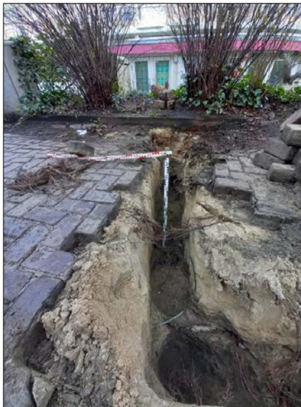
Sleuf haaks op kade (westkant boom) beperkte beworteling met tegen de kade diverse gestelwortels
