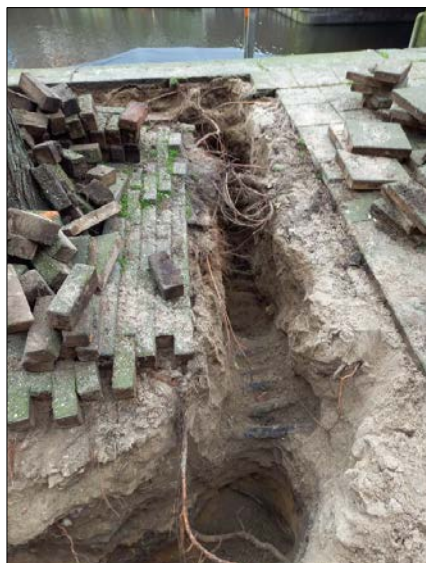
Kabelkluwe en oppervlakkige gestelwortels
