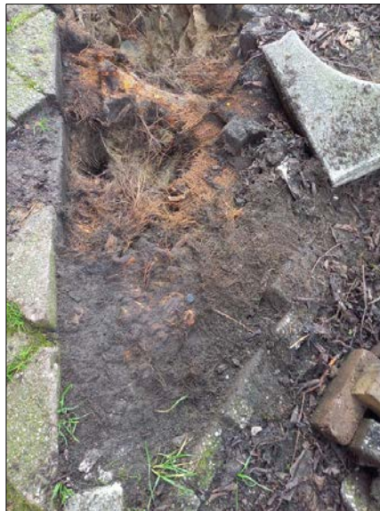
Close-up gestelwortels tegen straatwerk
