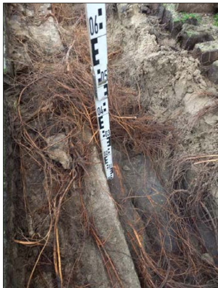
Zware gestelwortels op kademuur
