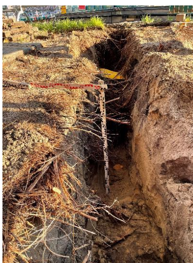
Proefsleuf tot 1 meter uitgezogen met fijnere beworteling in eerste 30 cm en aangetroffen gasleiding.
