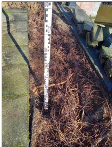
Zeer intensieve oppervlakkige haarbeworteling tegen kade
