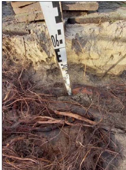
Close-up gestelwortels tegen kademuur
