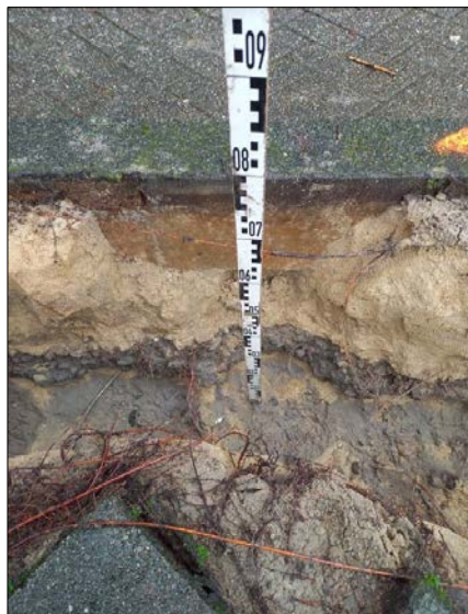
Granulaat onder straatwerk
