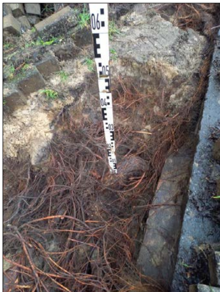
Zeer intensief pakket haarwortels tegen kade vlak onder bestrating, met daaronder dikke gestelwortels
