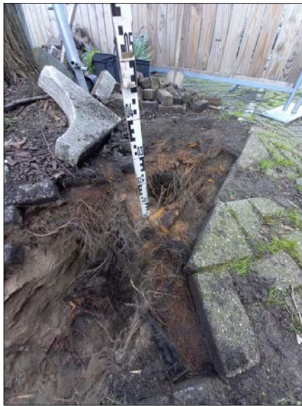
Zeer dikke plaat grillige gestelwortels tegen uitkragende muur
