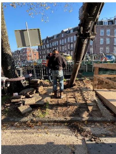
Overzicht van de werkzaamheden op Da Costakade tegenover huisnummer 26A
