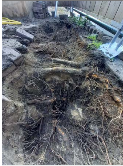
Dikkere gestelwortels liggen oppervlakkig en geven opdruk
