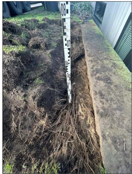
Haarwortels met uitkragende kade achterzijde boom 31
