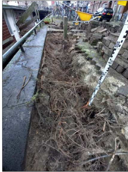
Dikkere oppervlakkige gestelwortels nabij kade, en tegen kade.
