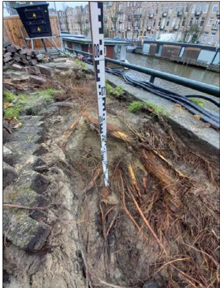
Zeer intensief pakket gestelwortels tegen kade vlak onder bestrating, met daaronder haarwortels.
