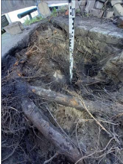
Dikke gestelwortels haaks op, en parallel aan kade met uitkragende kademuur
