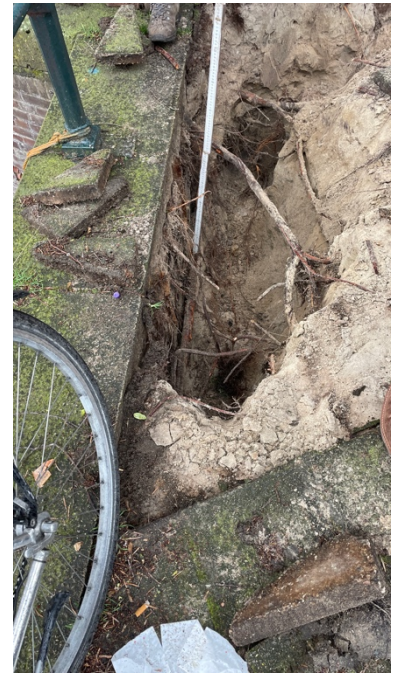
Afbeelding 19: Grovere beworteling (1,5 cm doorsnede) langs de kademuur
