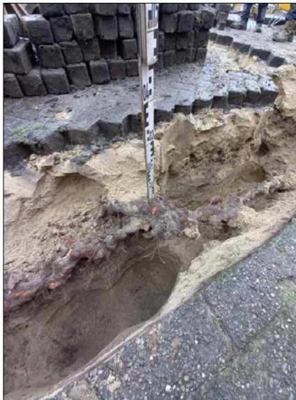
Grillige, oppervlakkige gestelwortels onder rijbaan.
