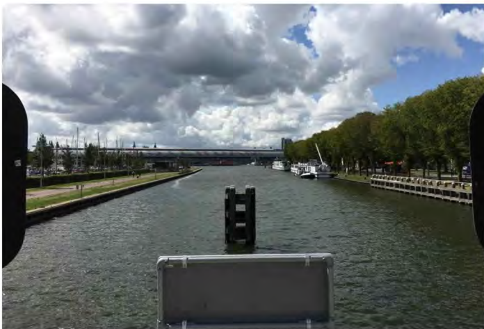
Zicht op de voorhaven vanaf de Willem I sluis
