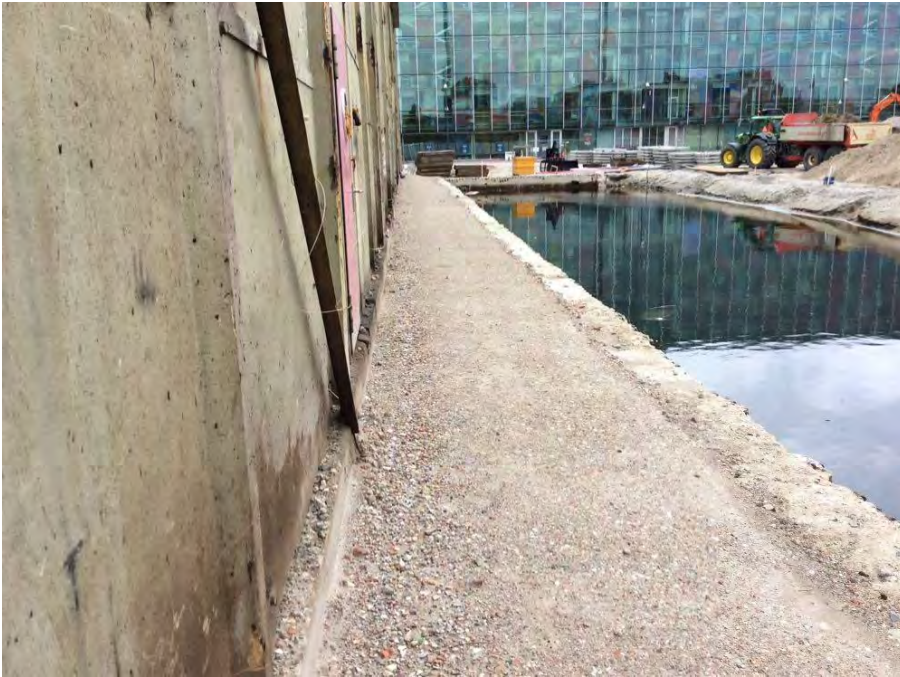
Strook tussen betonnen bak en hal
