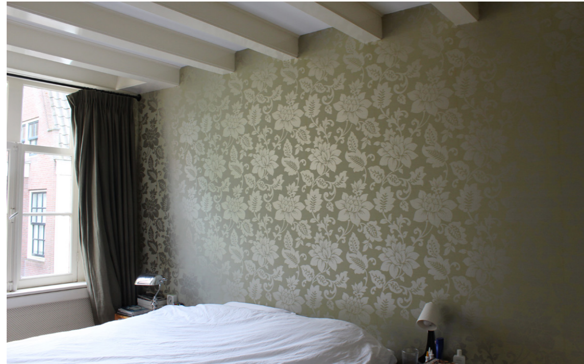
5.1, 2, e (ramen en dakbalken uit 1967)
