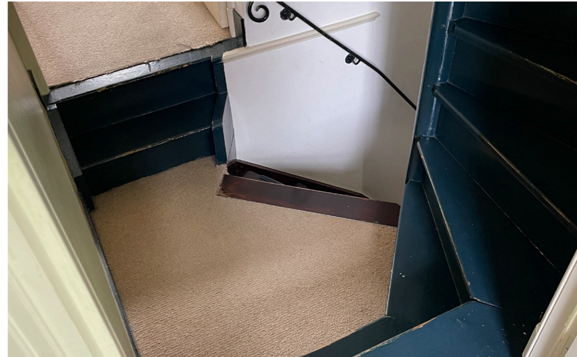
Bordes op de eerste verdieping
