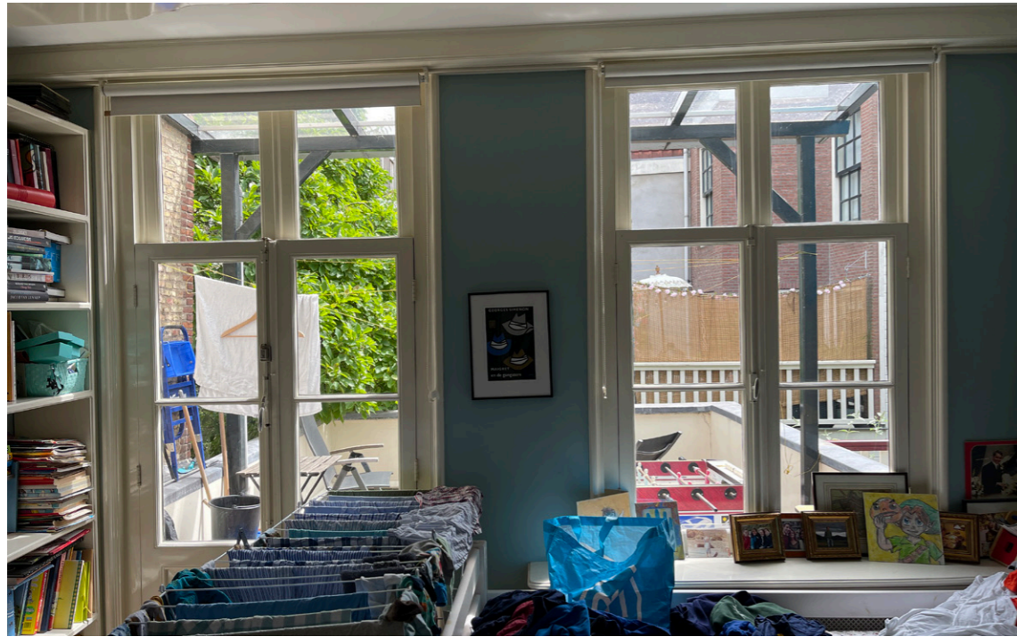
Ramen in achtergevel (daterend uit 1967)
