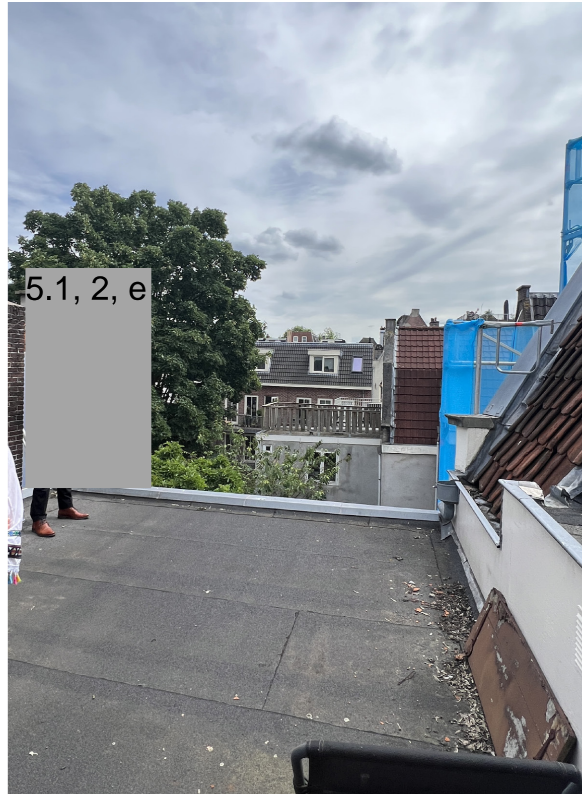
Plat dak 5.1, 2, e (ontstaan 1930-1947)
