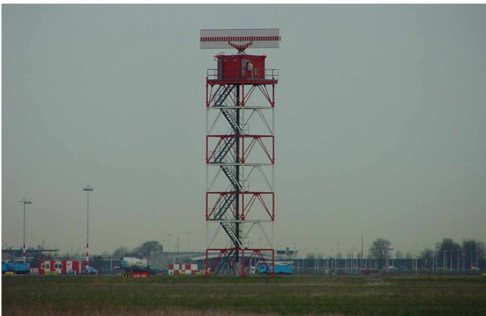
Figuur 71 De TAR Centrum MSSR gelegen tussen de taxibanen van Schiphol.
