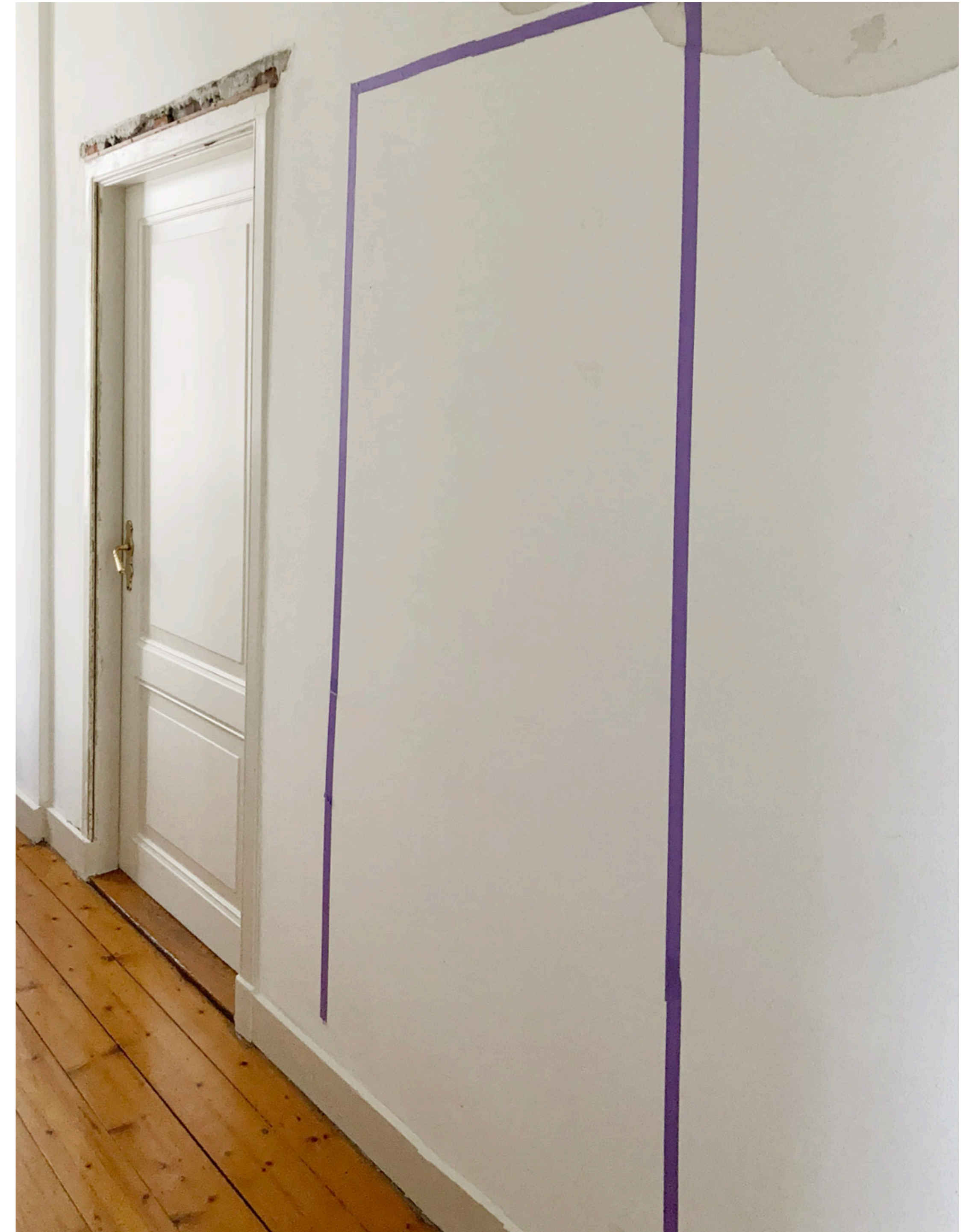
Hal aanzicht bestaande deuropening en markering nieuwe deuropening
