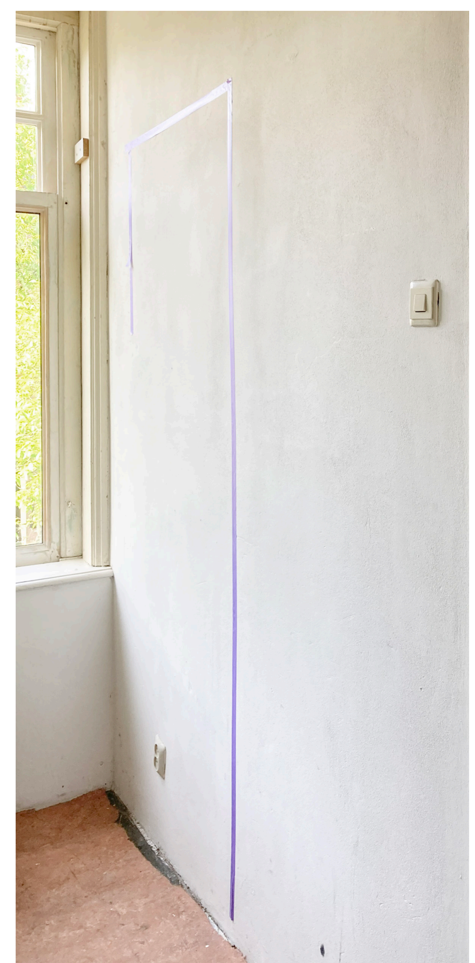
Kamer aanzicht nieuwe deuropening
