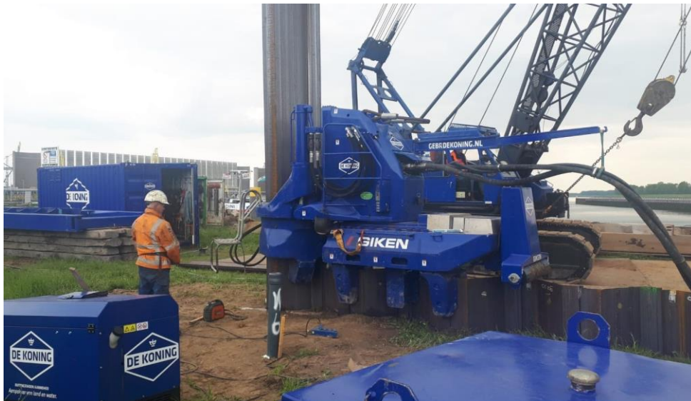
Figuur 3-7: Verwijderen damwand met Silent-piler
