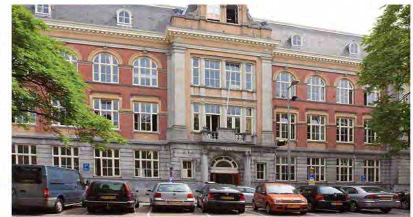
gevel HES gebouw
