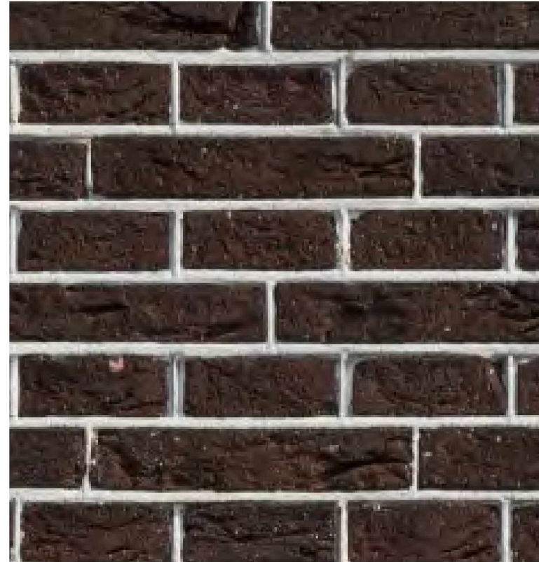
Bestaande metselwerk: vechtformaat, kruisverband met geknipte voeg
