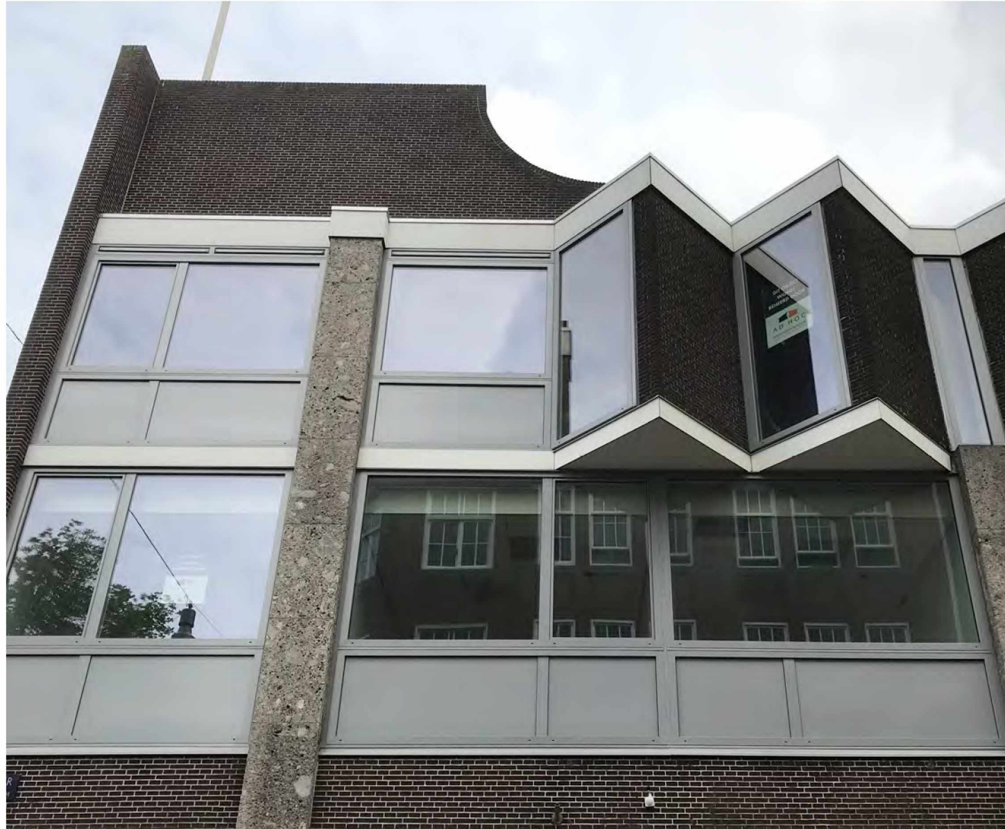
Huidige situatie (na vele renovaties)
