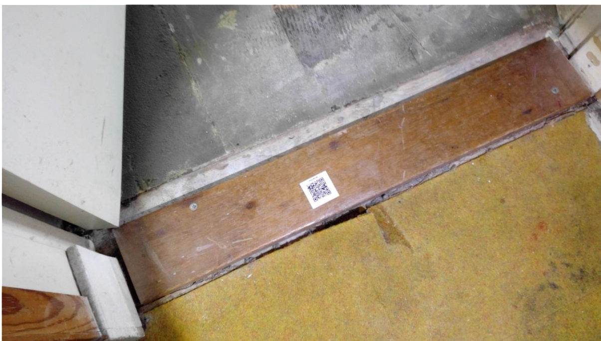
Foto F04 Vinyltegels met lijmlaag Hal
