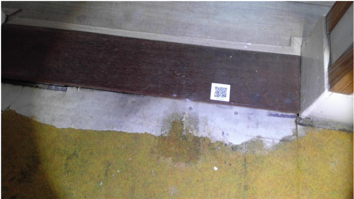
Foto F01 Onderlaag vloerzeil Hal
