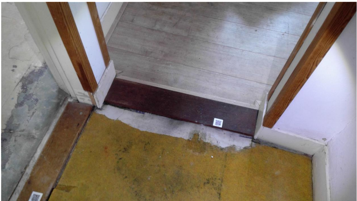
Foto F02 Onderlaag vloerzeil Hal
