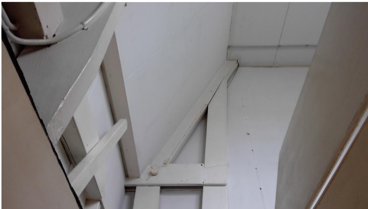
Foto F19 Gips dakbeschot berging.
