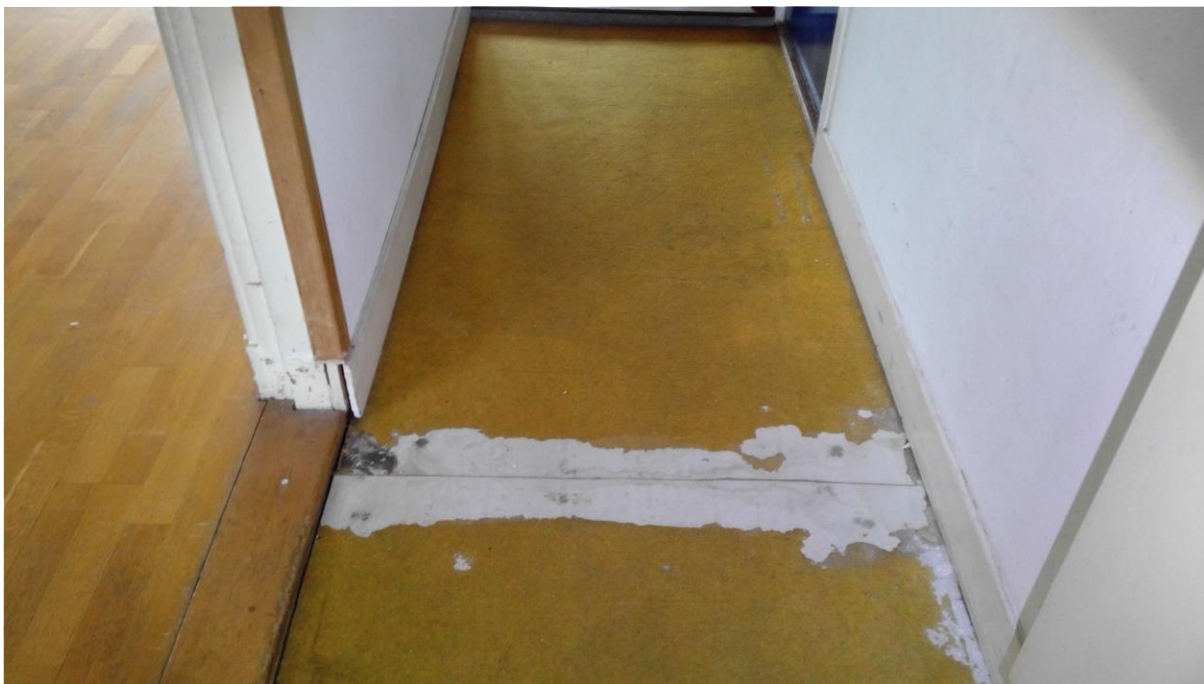
Foto F03 Onderlaag vloerzeil Hal
