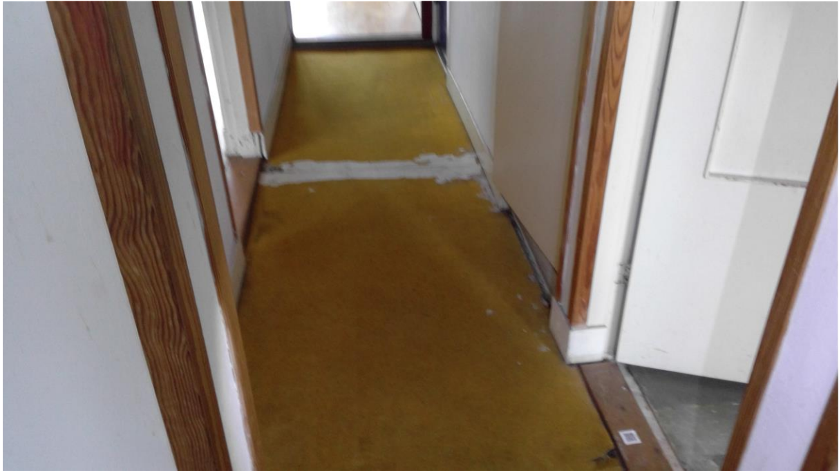
Foto F05 Vinyltegels met lijmlaag Hal
