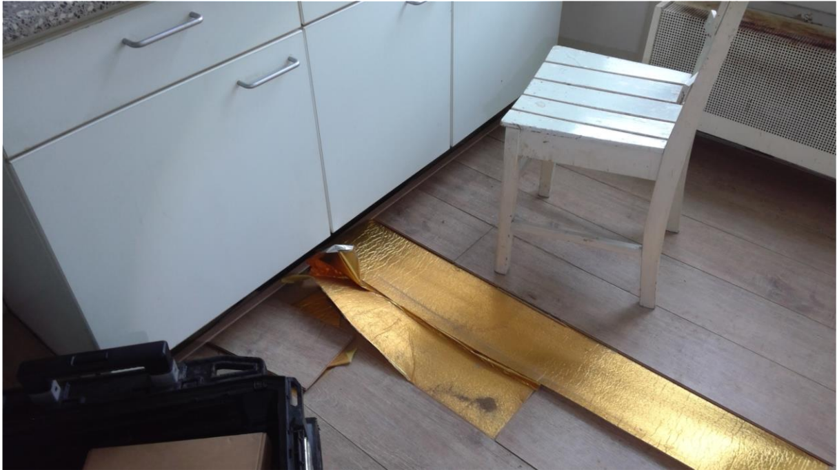
Foto F07 Vinyltegels met lijmlaag Keuken
