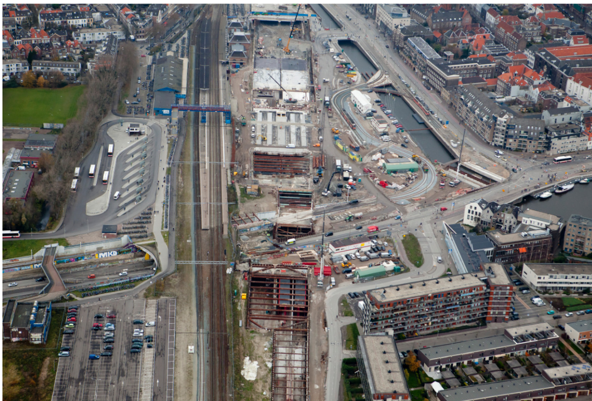
afbeelding 3 - centraal gelegen werkterrein Spoorzone Delft
