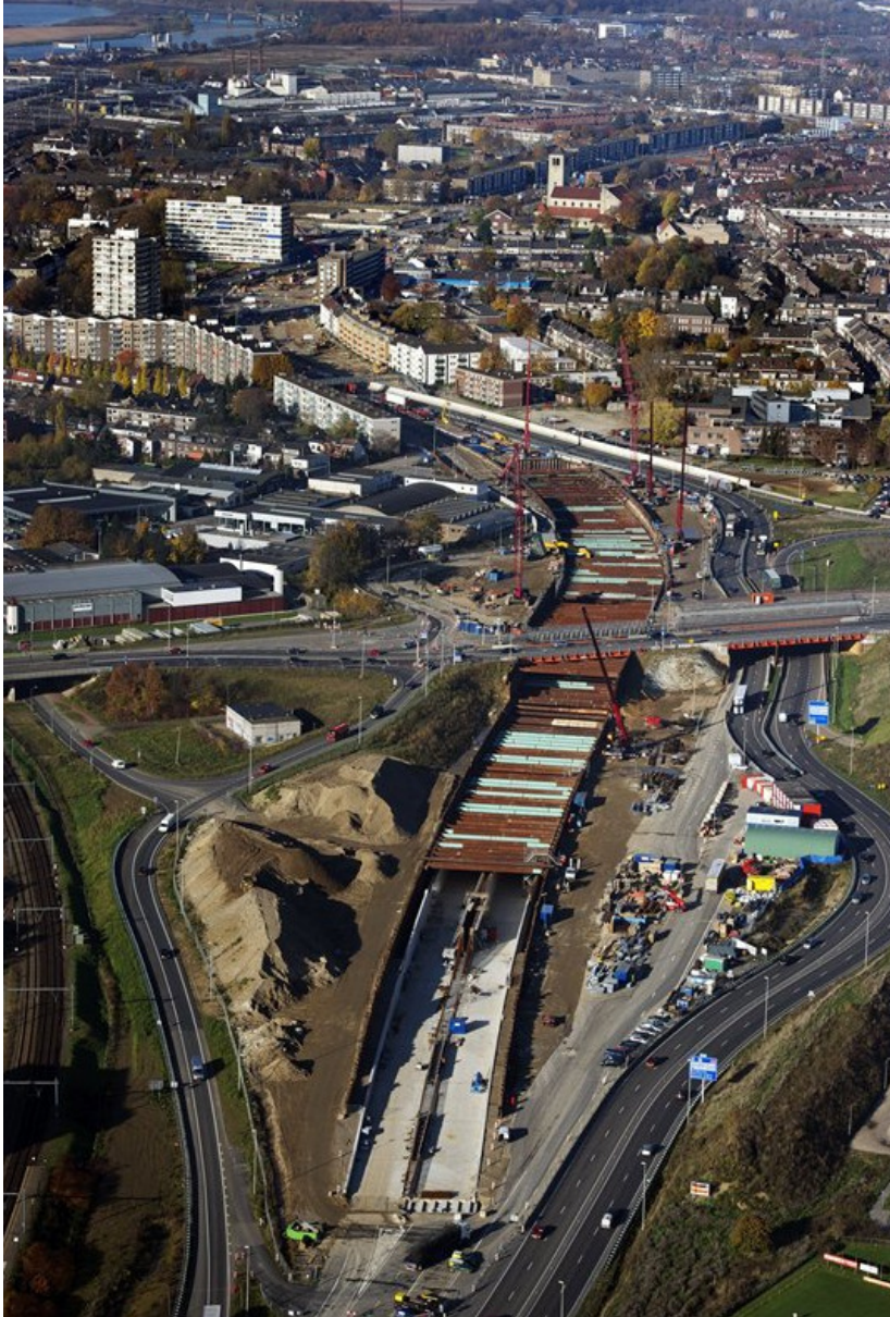
afbeelding 7: werkterrein A2-tunnel Maastricht
