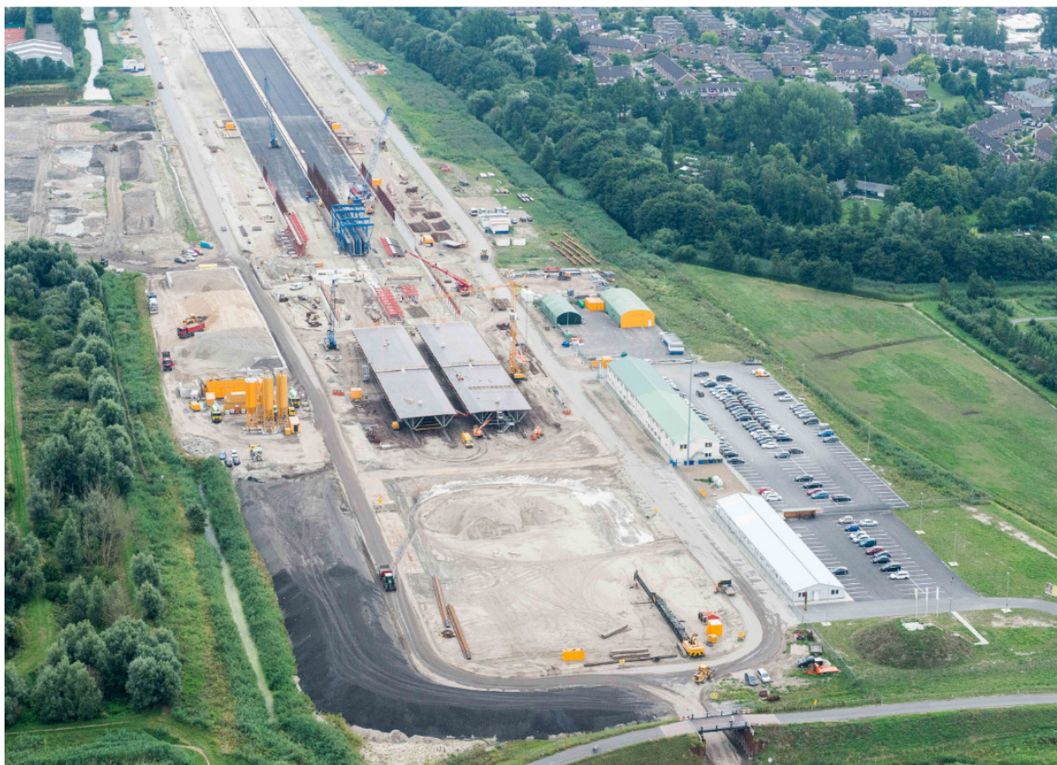
afbeelding 1 - Werkterrein A4-tunnel Delft-Schiedam
