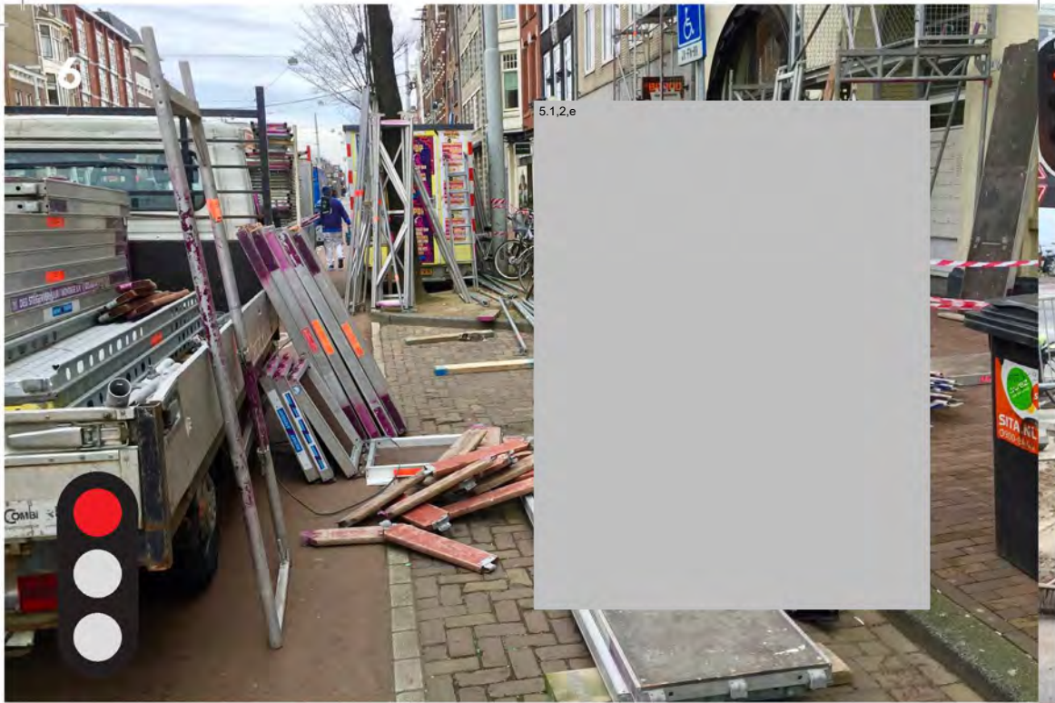
Ruim losse materialen altijd direct op of plaats het binnen de hekken.
