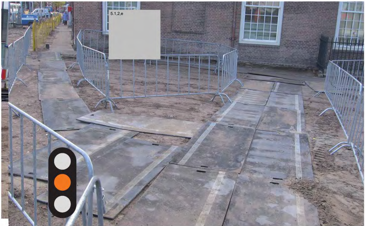
Goed aangeven waar de route is. Gebruik bij voorkeur lage dichte hekken.
