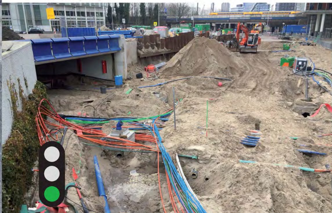
Kleur bij kleur. Een goed geordende aanleg én verleg spaart tijd en geld bij uitvoering in de toekomst.
