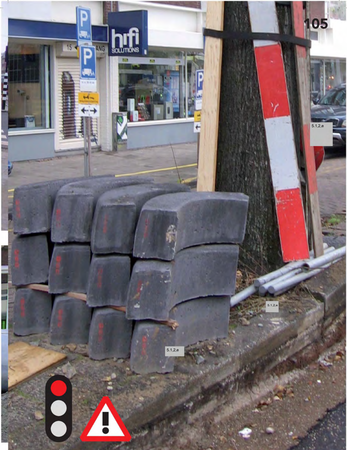
Plaats bouwmaterialen aan de voet van bomen altijd op plaatmateriaal zodat de wortels niet beschadigd raken door puntbelasting.
