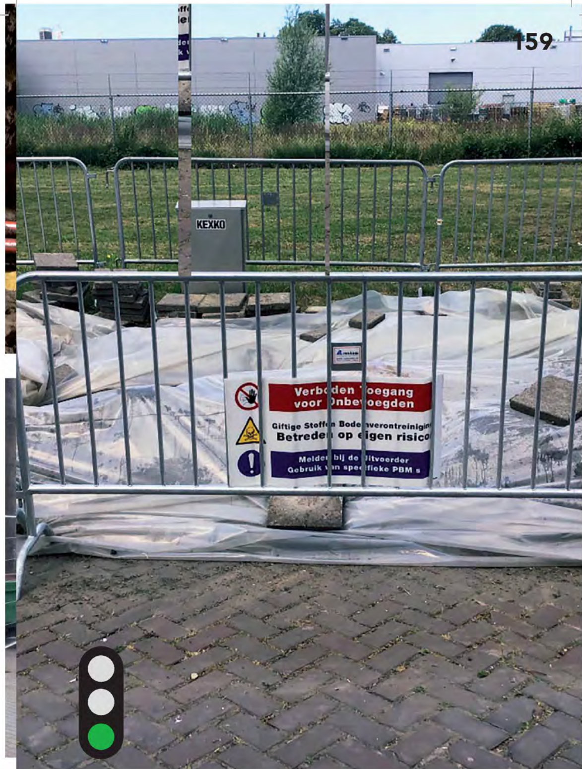
Verontreinigde grond keurig afgedekt en voorzien van een waarschuwingsbord.
