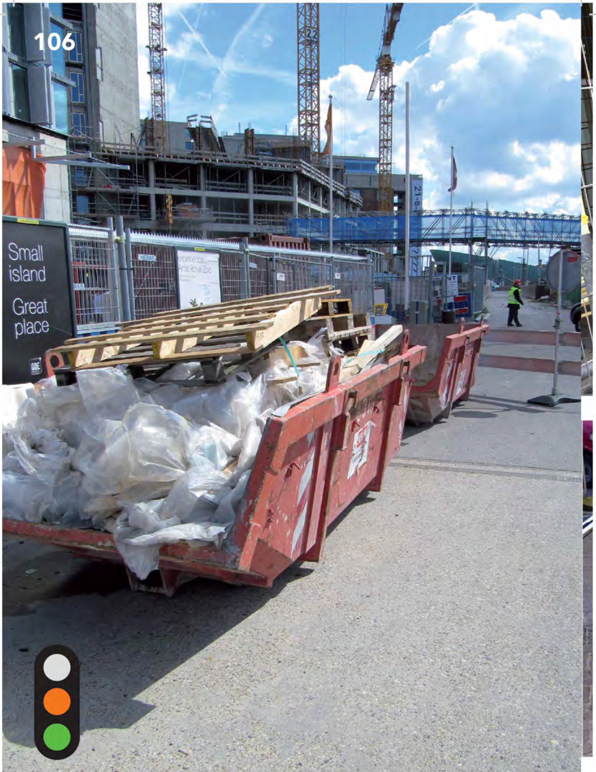
De centrale afvalplaats hoort binnen het werkvak. Centrale plek voor bouwafval voorkomt zwerfafval.
