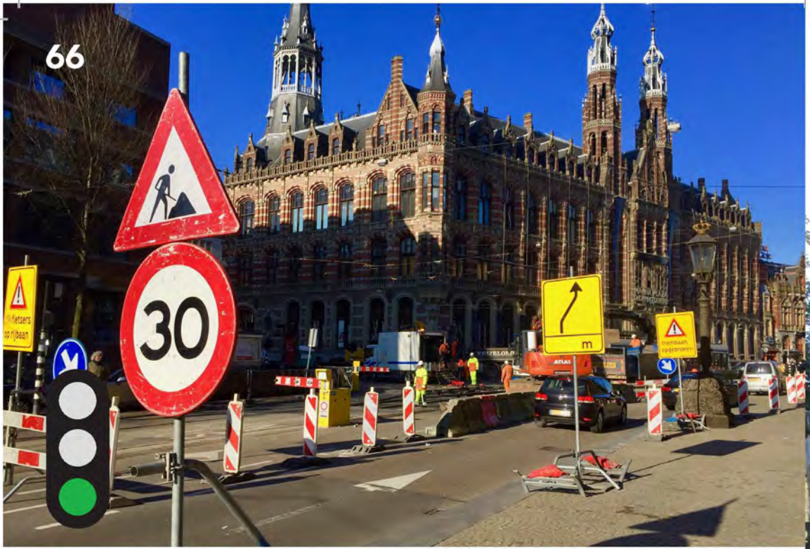
Klaphekjes sluiten het werkvak af en zorgen ervoor dat er geen verkeer inrijdt.
