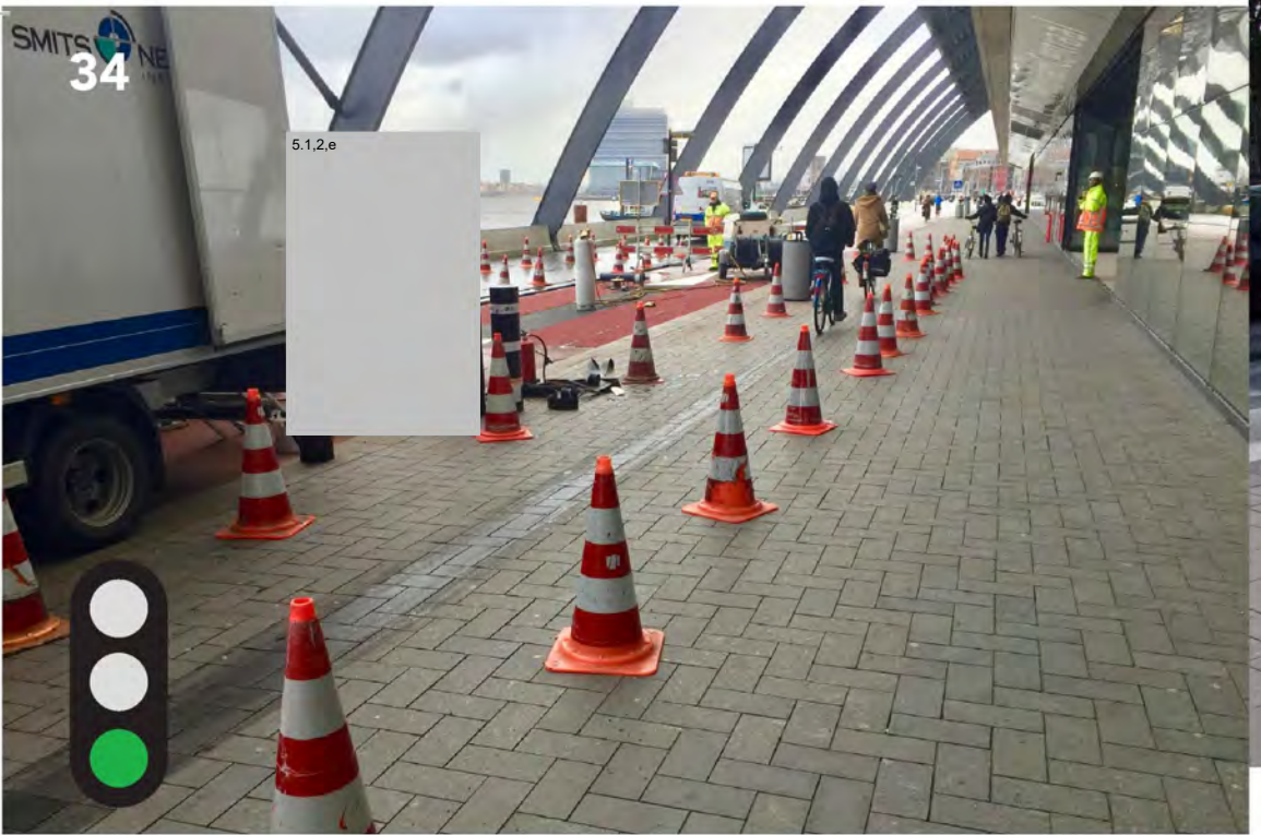
Fietsers bij kortdurende werkzaamheden via voetpad, afgescheiden van voetgangers.
