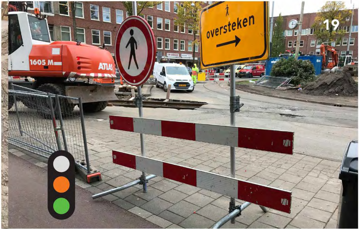
Goed aangeven waar de route is. Gebruik bij voorkeur lage dichte hekken. Looproute goed aangeven.
