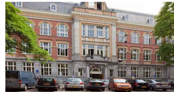
gevel HES gebouw
