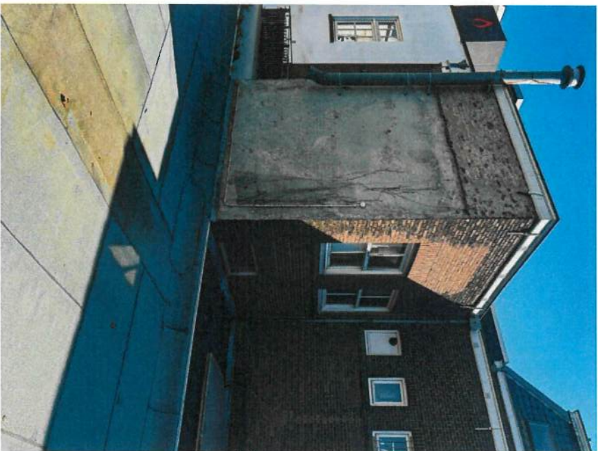
Bestaande kanalen achtergevel
