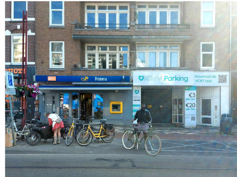
gebouwdeel A De huidige plint aan de 5.1.2,e Links - op nummer 49 - detailhandel en rechts de entree van de stallingsgarage.
