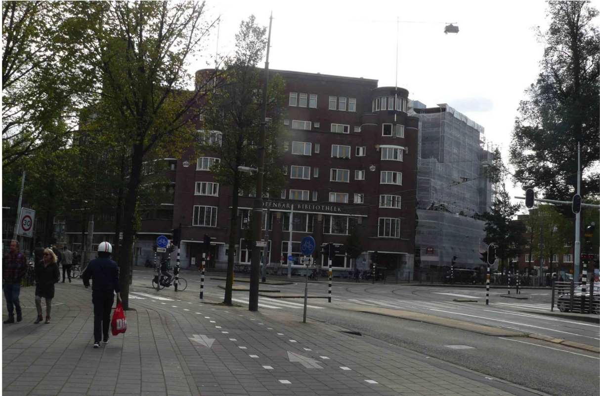
Afbeelding 1 Vooraanzicht van het gebouw.
