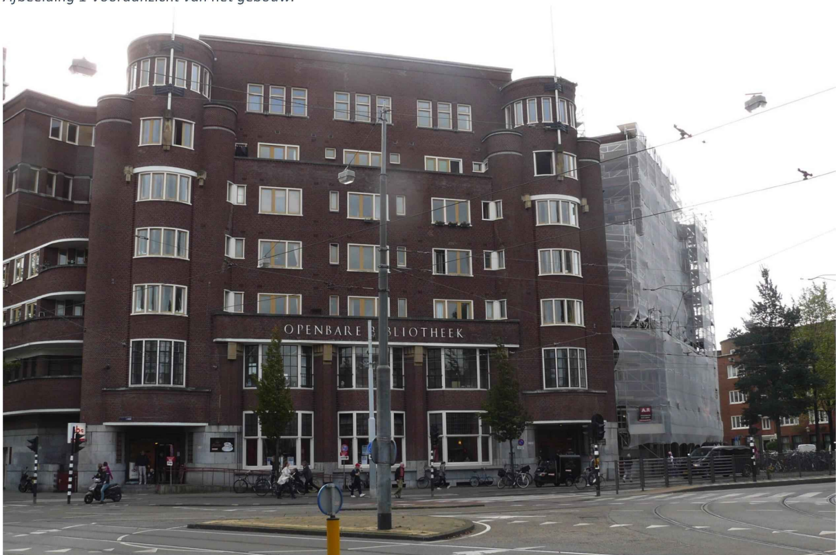
Afbeelding 2 Vooraanzicht van het gebouw.
