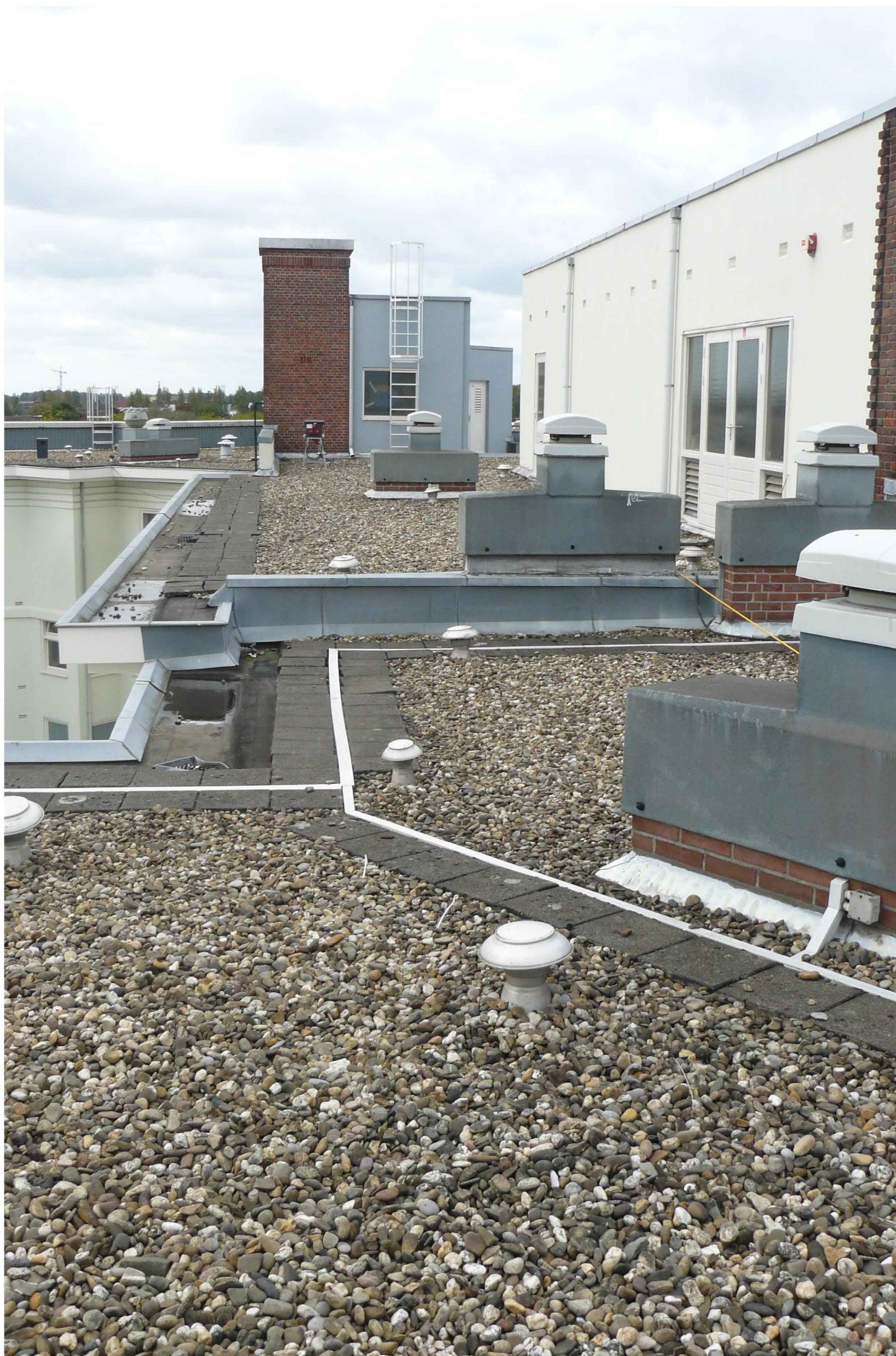
Afbeelding 7 Zicht op achterkant van de dakopbouw.
