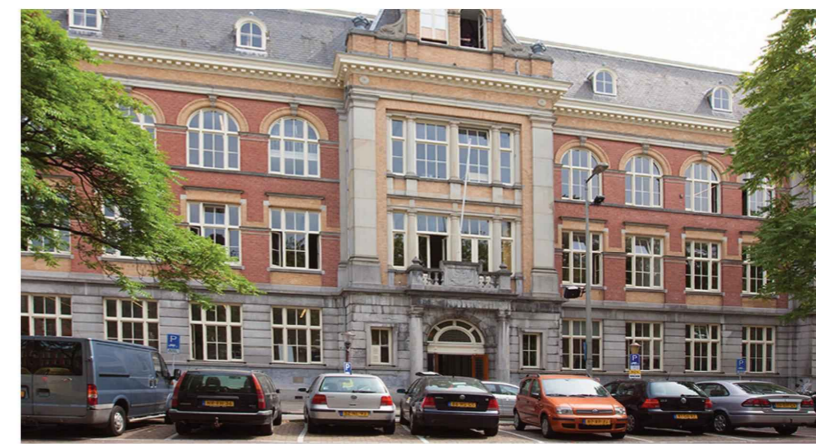
gevel HES gebouw
