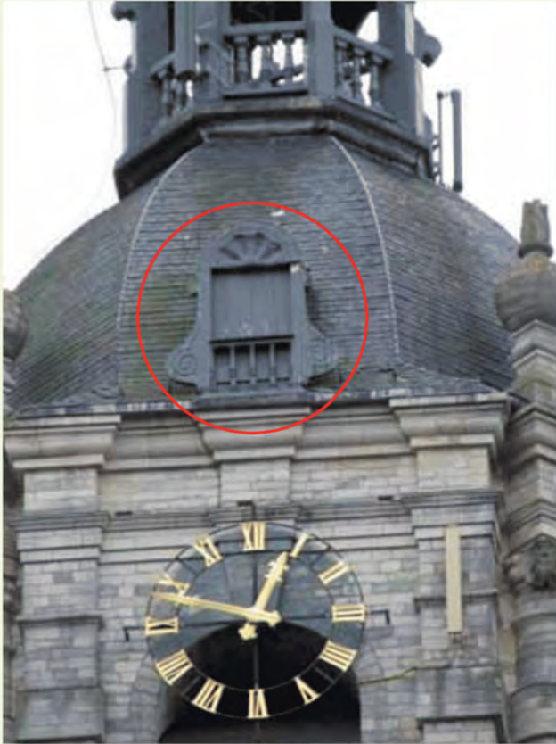
Antennes komen achter de deur en balustrade
