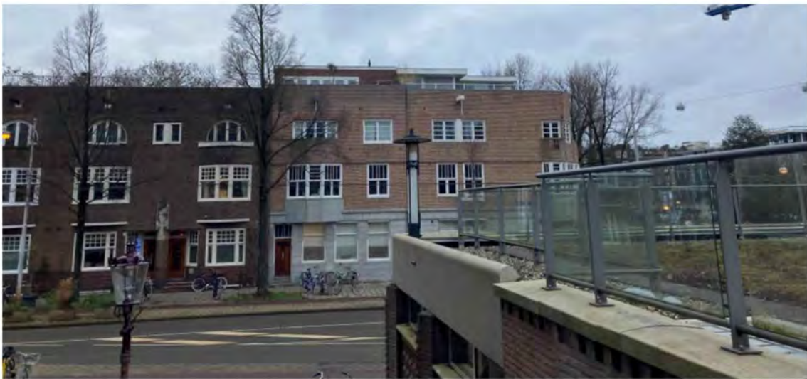
Gevel zijde Corn. Krusemanstraat met dakopbouwen. Gezien vanaf het hoger gelegen Valeriuusterras aan de overkant.
