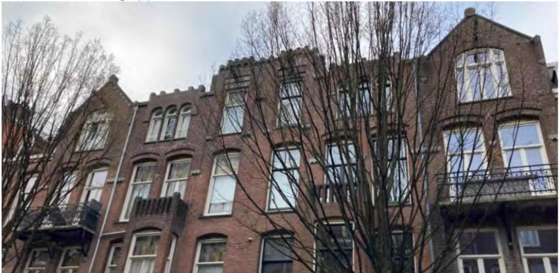
Gevelarchitectuur Nicolaas Maesstraat 66-76.
