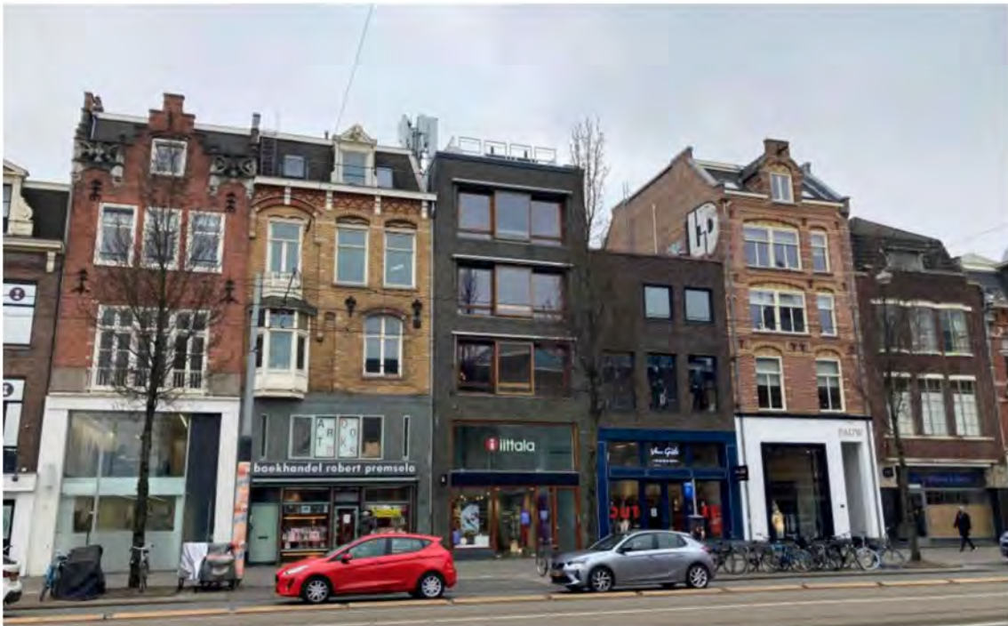
Gevelaanzicht vanaf de Van Baerlestraat.
