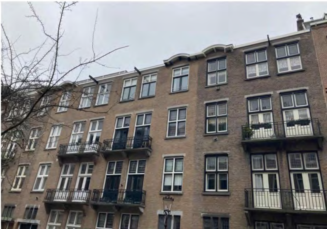
De gevel gezien vanaf de Valeriusstraat.
