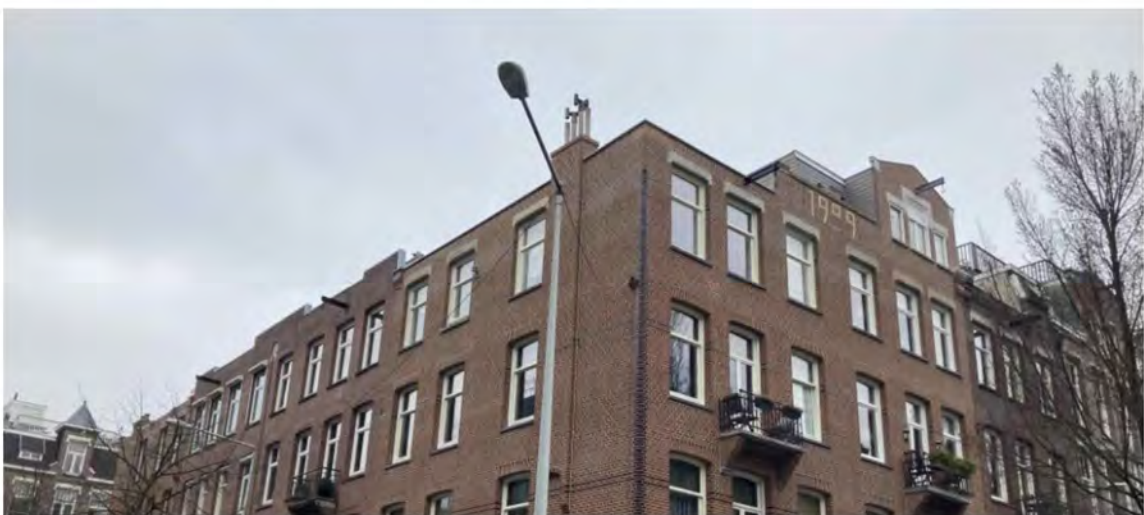
Hoek Lassusstraat / Joh. Verhulststraat. Op deze hoek is positief geadviseerd over een extra bouwlaag, maar deze is (nog?) niet gerealiseerd.
