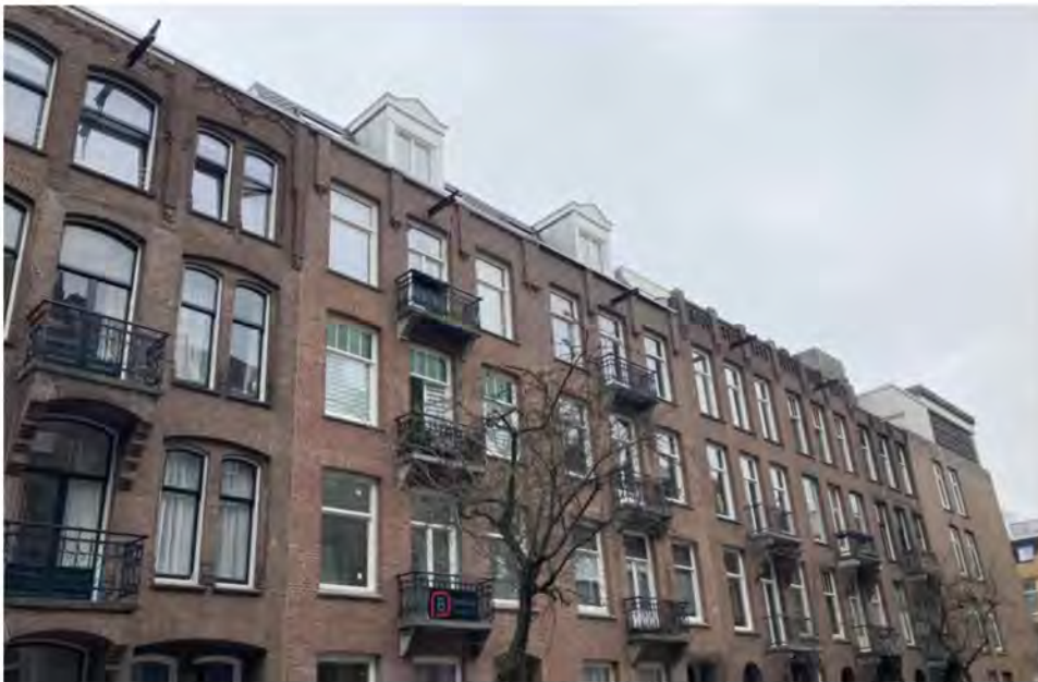
Recente foto met daarop de extra bouwlagen in de vorm van een kap die hier al zijn gerealiseerd.
