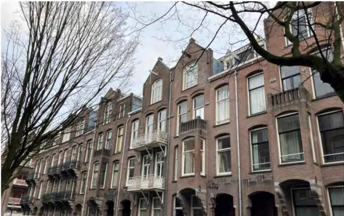
Gevelarchitectuur Nicolaas Maesstraat 73-89.
