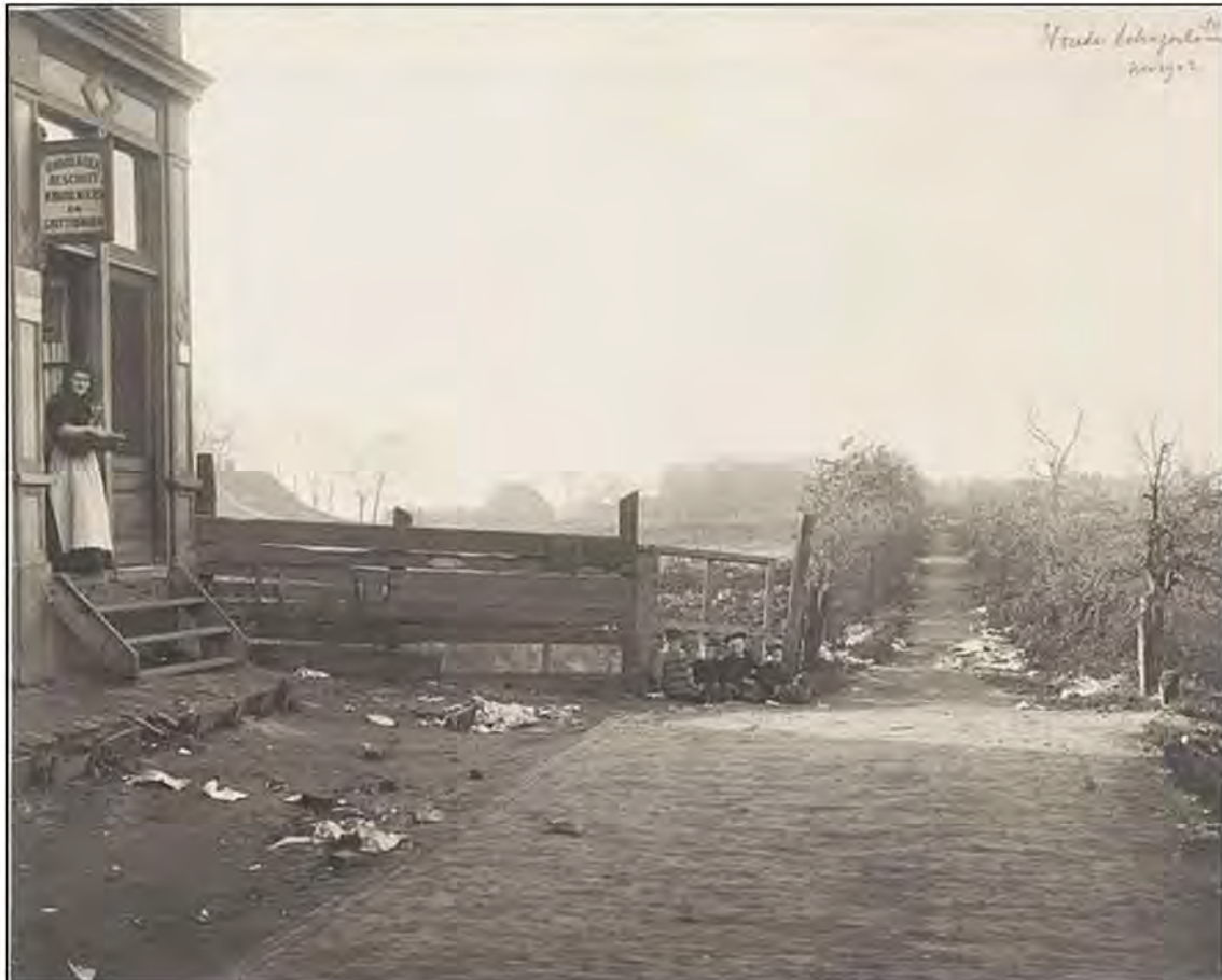
6 Ruysdaelstraat 89 lag in 1902 op het nieuwe stadspeil, terwijl de Schagerlaan op de achtergrond nog op het oorspronkelijk polderpeil lag (SAA).
