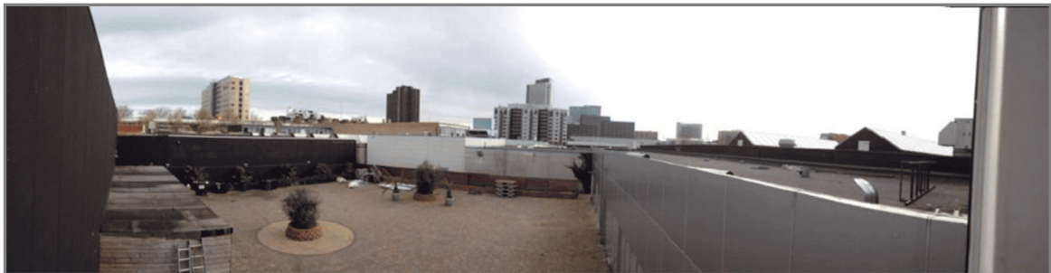
3. Achtergevel Edessa met zicht op binnentuin
