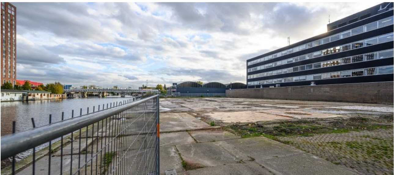
Terrein van het projectlocatie na sloop bestaande gebouwen
