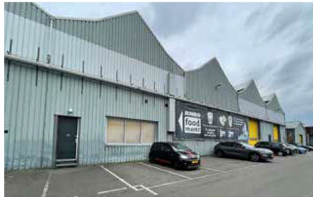
2. Karakteristieke metselwerk zuid- en westgevel is vermoedelijk ingepakt met isolatie en beplating
