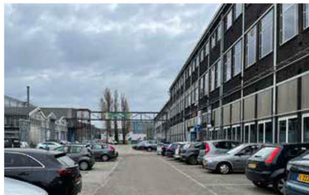
15. Aan de oostgevel met ijzeren skelet en bakstenen invulling en ramen is te zien dat het zuidelijke deel eerder is gebouwd dan het iets hogere noordelijke deel
