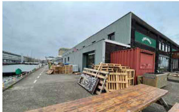
8. Karakteristieke metselwerk westgevel vermoedelijk ingepakt met isolatie en beplating
