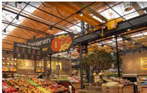
3. Oorspronkelijke, lichtgewicht constructie aanwezig met ijzeren vakwerkkolommen en herkenbare dakvorm op vakwerkspanten. Oost-west gelegen lichtstraten voorzien van daglicht
