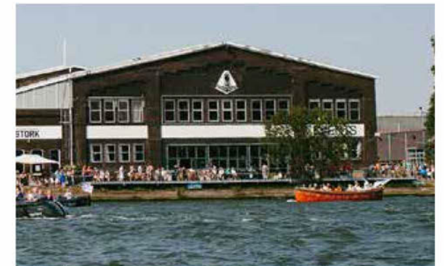
17. De zuidgevel met verdiepte metselwerkvlakken en karakteristieke baksteendetails is beeldbepalend, de gevelindeling is nagenoeg authentiek maar de ramen zijn allemaal vernieuwd
