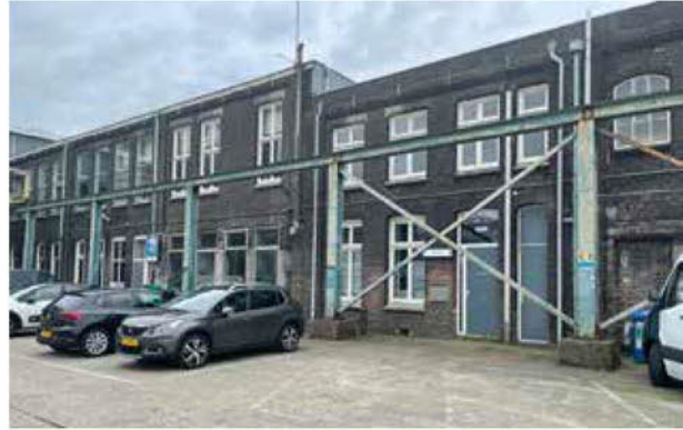
7. De bakstenen noordgevel met verdiepte vlakken is oorspronkelijk, enkele openingen zijn aangepast
