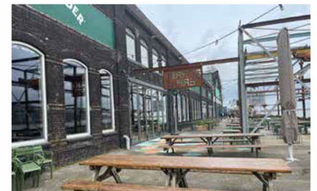
12. De zuidgevel met verdiepte metselwerkvlakken en horizontale banden van gele steen is beeldbepalend, de ramen zijn allemaal vernieuwd
