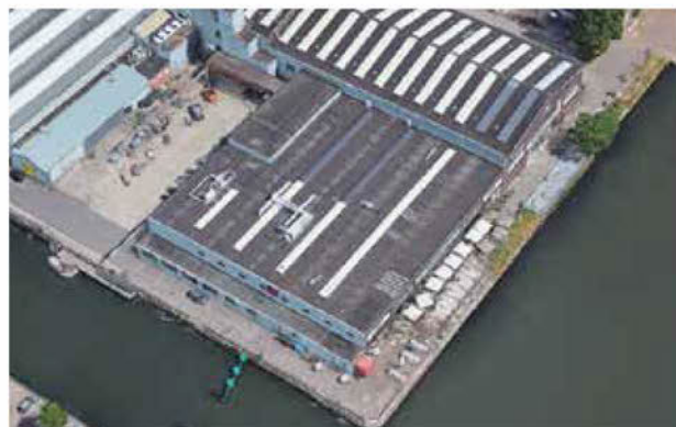
9. Oorspronkelijk was er een sheddak, dit is tussen 1974 en 2006 vervangen door een betonnen dak met lichtstraten
