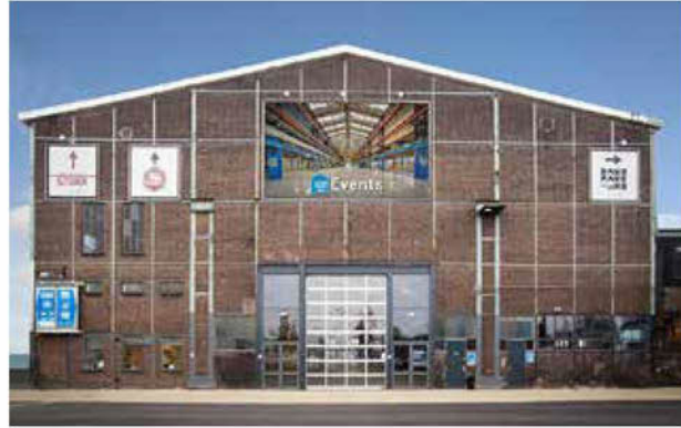
13. De noordgevel heeft een gevelopzet met ijzeren skelet en bakstenen invulling
