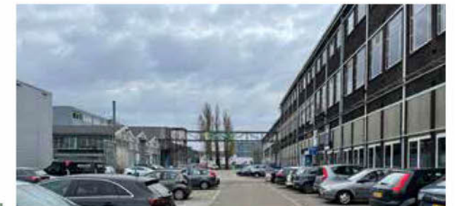
Fabrieksstraat. Lange zichtlijn naar het IJ begeleid door de kromhouthal. Voornamelijk asfalt en autoparkeren, met aan de kade twee bomen.
