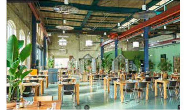
10. Staalskelet met kolommen en liggers in beide richtingen, waarschijnlijk jonger dan het gebouw en vernieuwd toen het dak is vernieuwd
