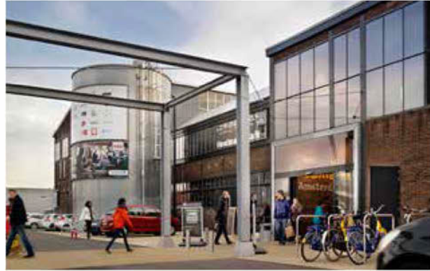
1. In de noordgevel is de constructie van de gevel met staalskelet en baksteen invulling nog goed zichtbaar
