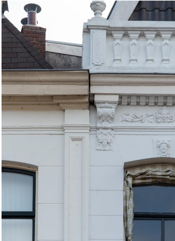
Afb. 3.3 - Linker aansluiting straatgevel nr. 131-132 Gemeenschappelijke bouwmuur
